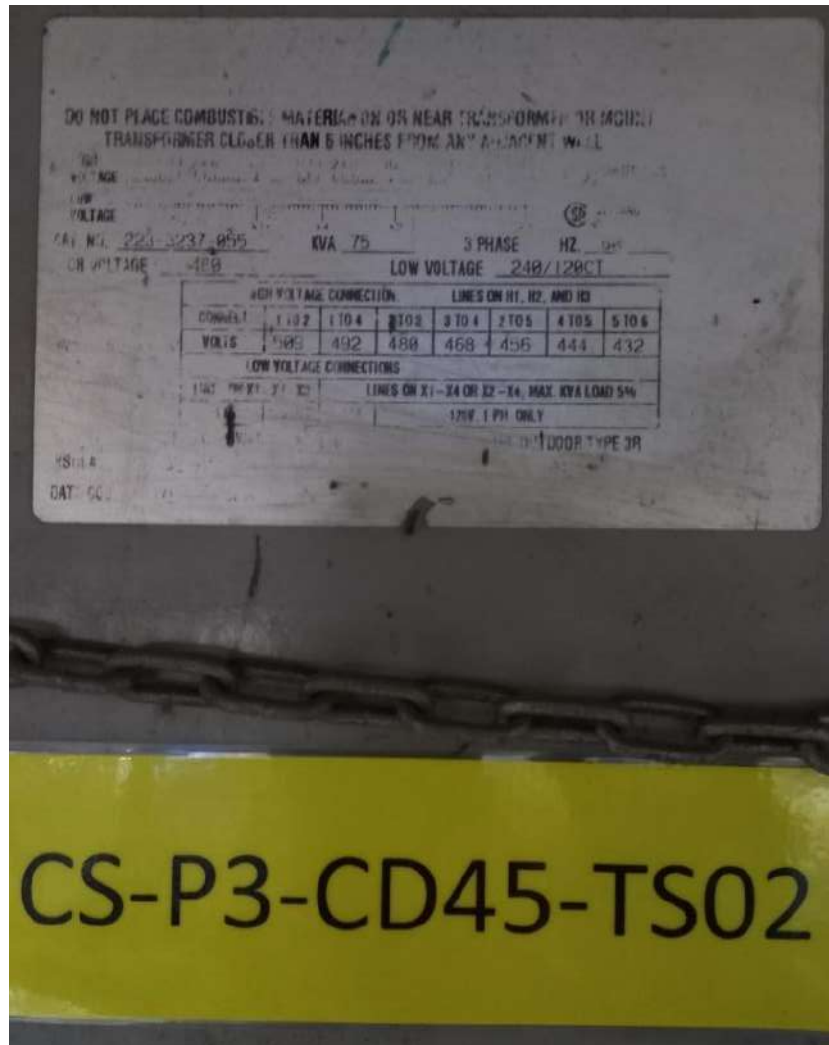
Figura 94. Datos de placa Transformador CS-P3-IJ45-TS01 Fuente: Elaboración propia (2023).
