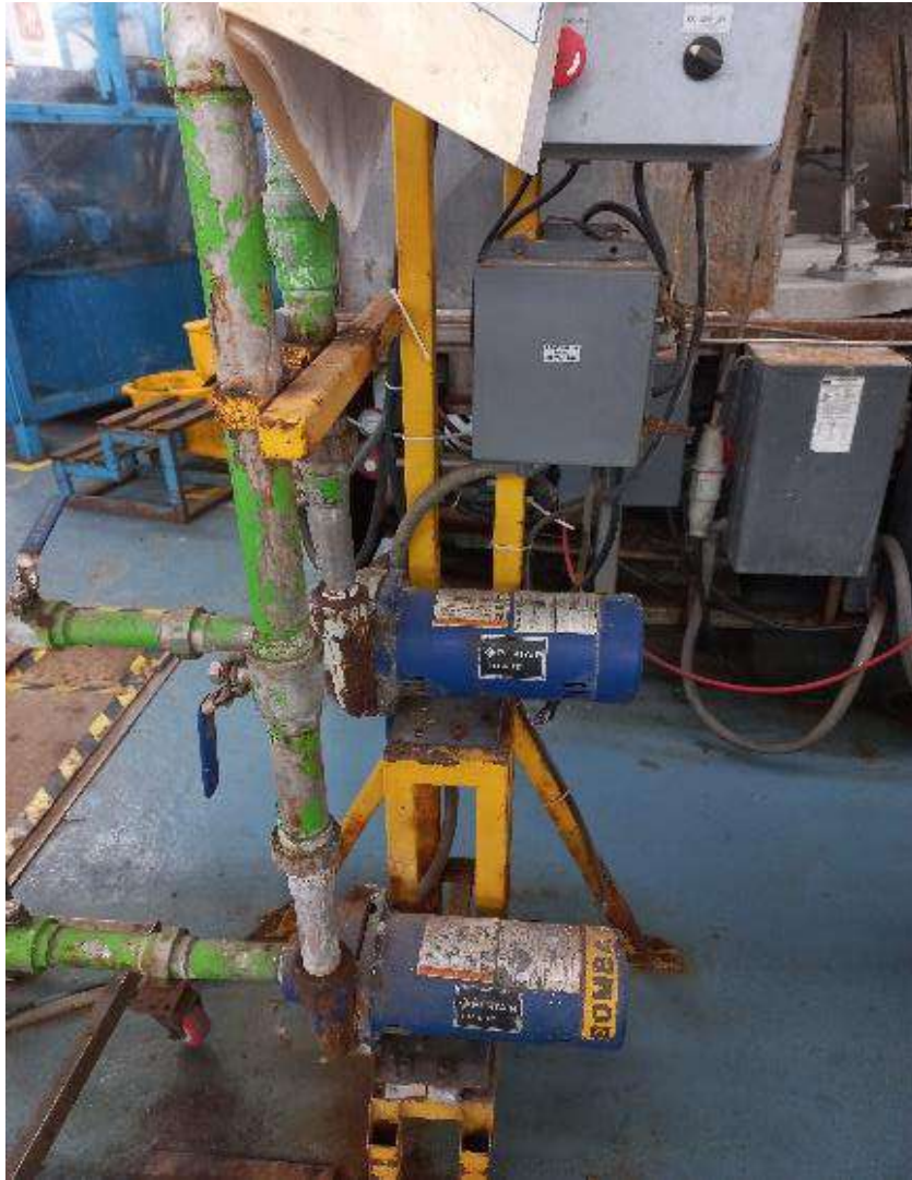
Figura 89. Sistema de recirculación de agua para carruseles Fuente: Elaboración propia (2023).
