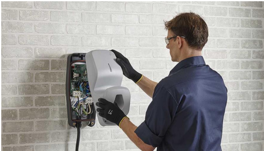
Imagen 6. Ejemplo de instalación de un modelo de cargador tipo Wallbox , usualmente para su montaje, el encapsulado del cargador debe ser abierto en su totalidad, labor que se realiza por un técnico profesional. Fuente: CTS.
