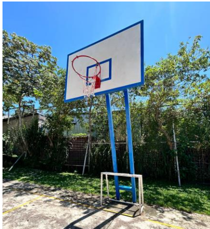
Figura 47. Equipamiento en Cancha multiuso Parque de San Vicente
