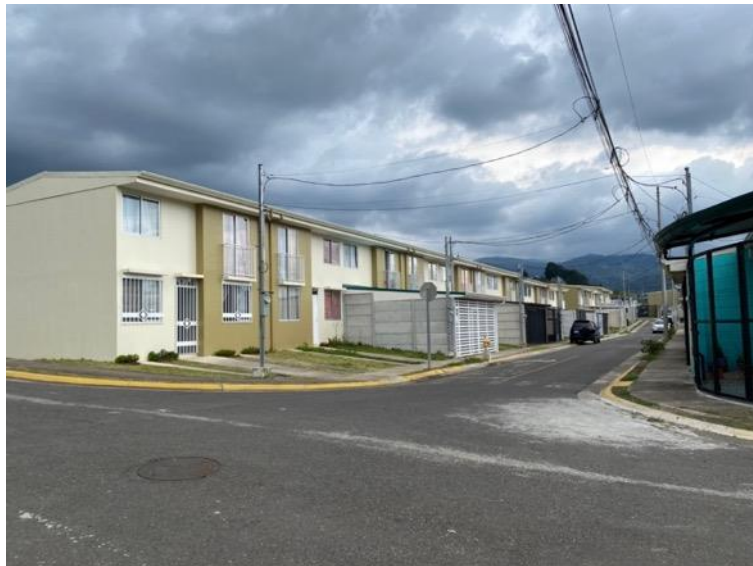
Figura 5. Viviendas construidas en la Etapa 6 del proyecto.
