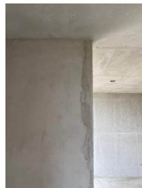
Figura 8. Repello muros.
