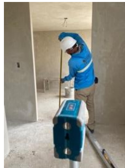
Figura 48. Revisión del procedimiento de medición de la horizontalidad utilizando el método 2.
