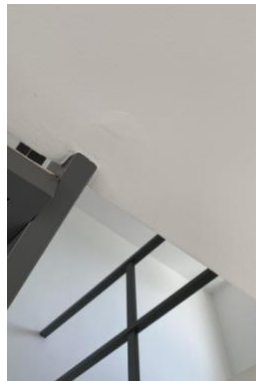
Figura 15. Repello cielo raso.
