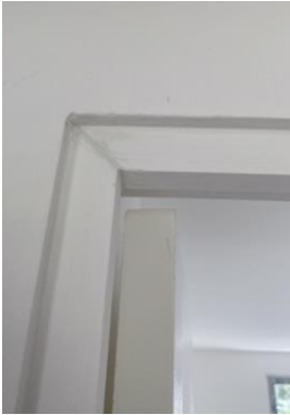
Figura 29. Pintura marco de puertas.
