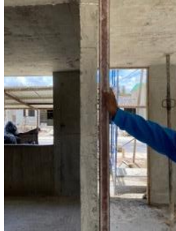
Figura 50. Revisión del procedimiento de medición de la rectitud.
