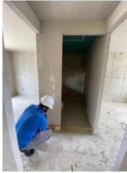
Figura 45. Revisión del procedimiento de medición de las dimensiones.
