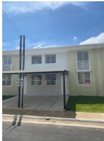
Figura 14. Fachada principal de las viviendas.
