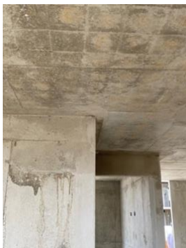
Figura 3. Resane de paredes.
