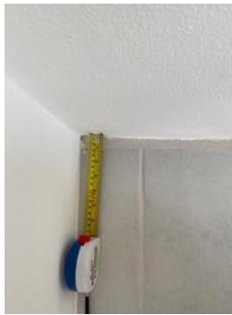
Figura 46. Revisión del procedimiento de medición del espacio entre elementos.
