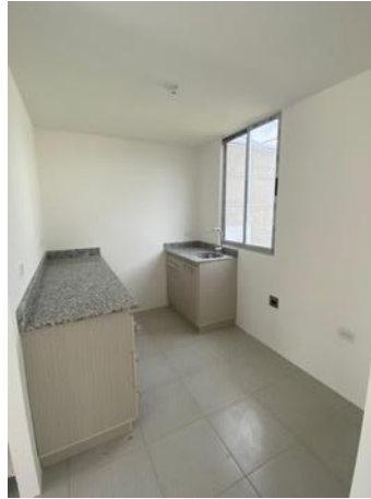
Figura 16. Cocina de las viviendas.
