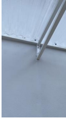
Figura 51. Cubierta de techo de pilas corta.
