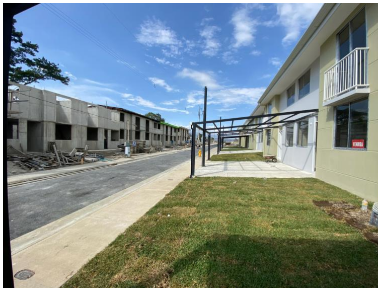
Figura 6. Condominio Vistas del Bosque en construcción.
