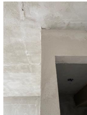
Figura 7. Repello muros.
