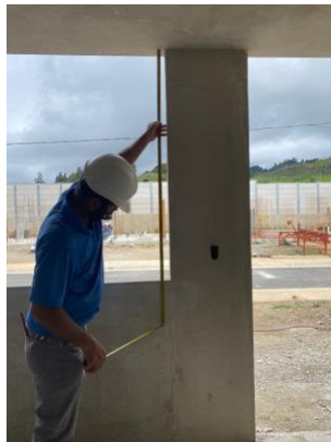
Figura 56. Capacitación del personal: caso práctico, revisión de dimensiones de buque de ventana.
