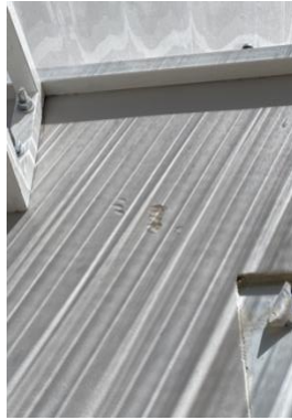
Figura 13. Repello fachada trasera.
