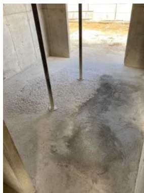
Figura 5. Losa de fundación.
