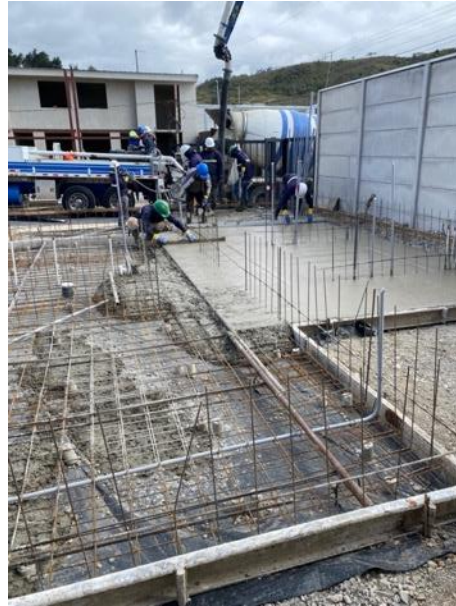
Figura 9. Actividad constructiva: colado de concreto para losa de fundación.
