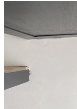
Figura 18. Repello paredes de gradas.
