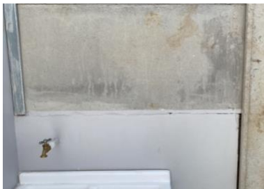
Figura 21. Repello muro pilas.
