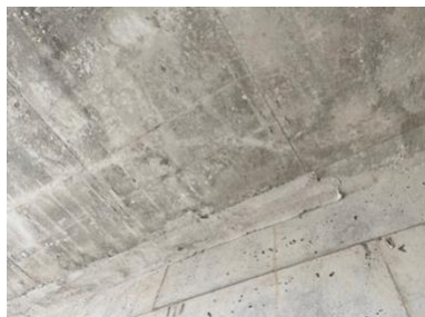
Figura 2. Resane de losa de entrepiso.
