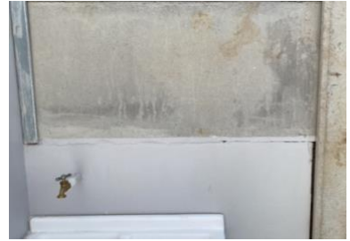
Figura 16. Repello muro pilas.
