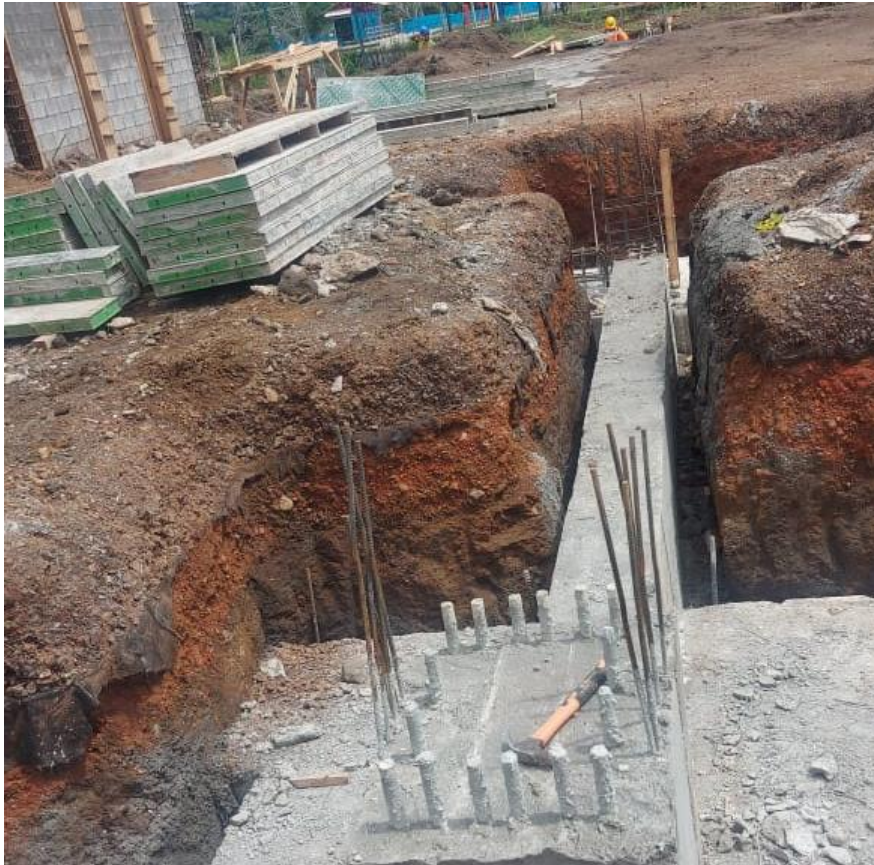
Figura 38. Retiro de formaleta.
