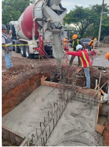
Figura 29. Estado futuro colocación de concreto.
