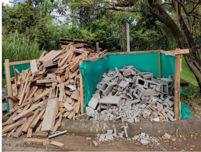
Figura 33. Espacio de desecho de madera y escombros.
