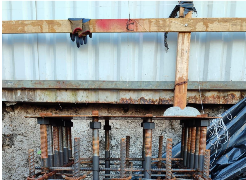
Figura 39. Equipo de seguridad a la intemperie.
