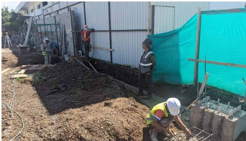
Figura 30. Control de calidad por parte del maestro de obras.
