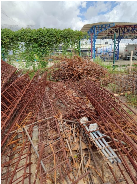
Figura 36. Depósito de acero de refuerzo extraído.
