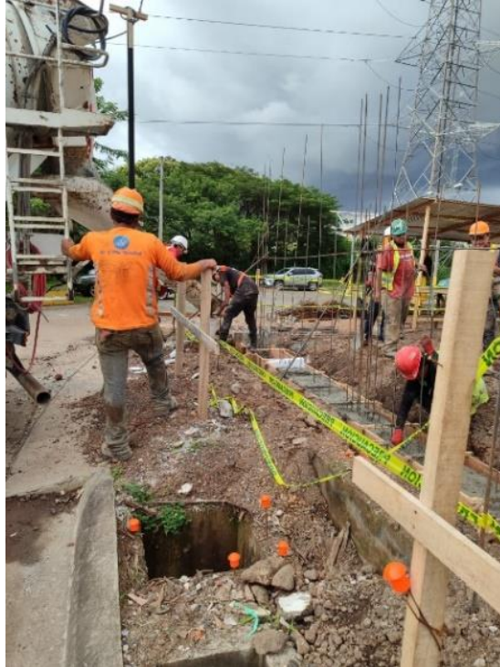
Figura 25. Estado actual de colocación de concreto.
