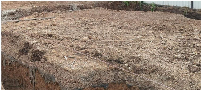
Figura 42. Desechos de estructura demolida y del proceso de colocado de armadura.
