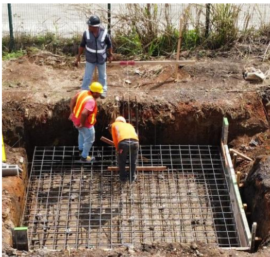
Figura 24. Estado actual colocación de armadura.
