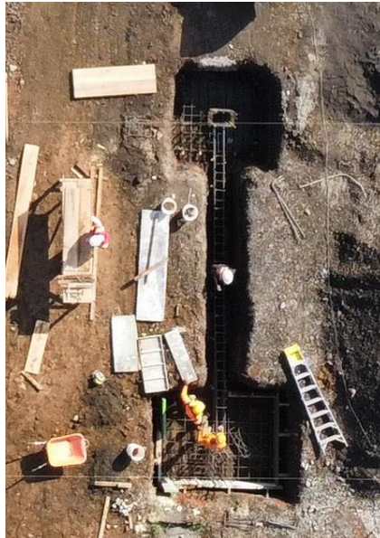
Figura 28. Colocación de armadura.
