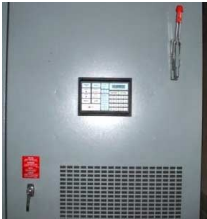
Figura A.4.8 Panel de control de parámetros de operación para el bombeo
