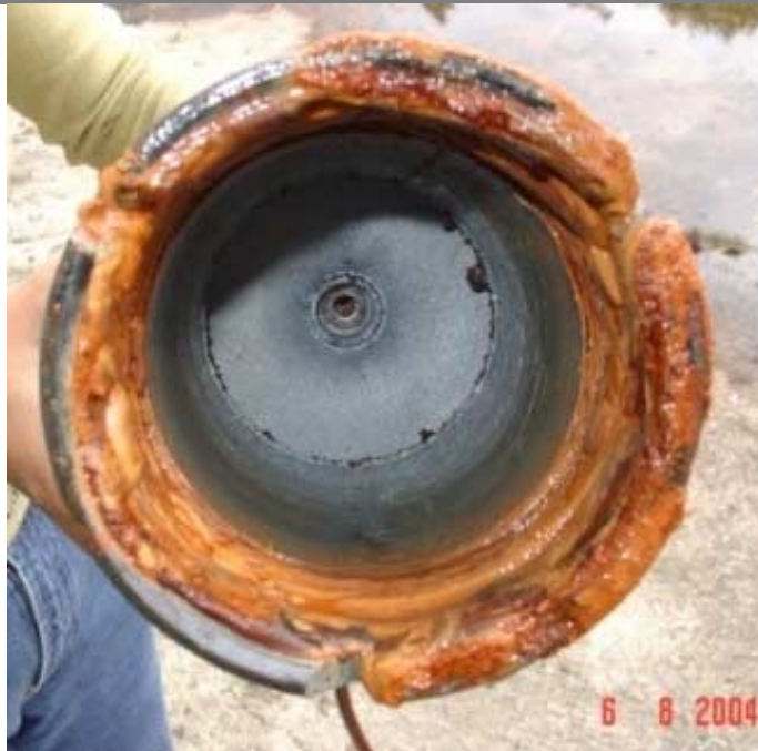
Figura A.4.13 Campana captadora de presión.
