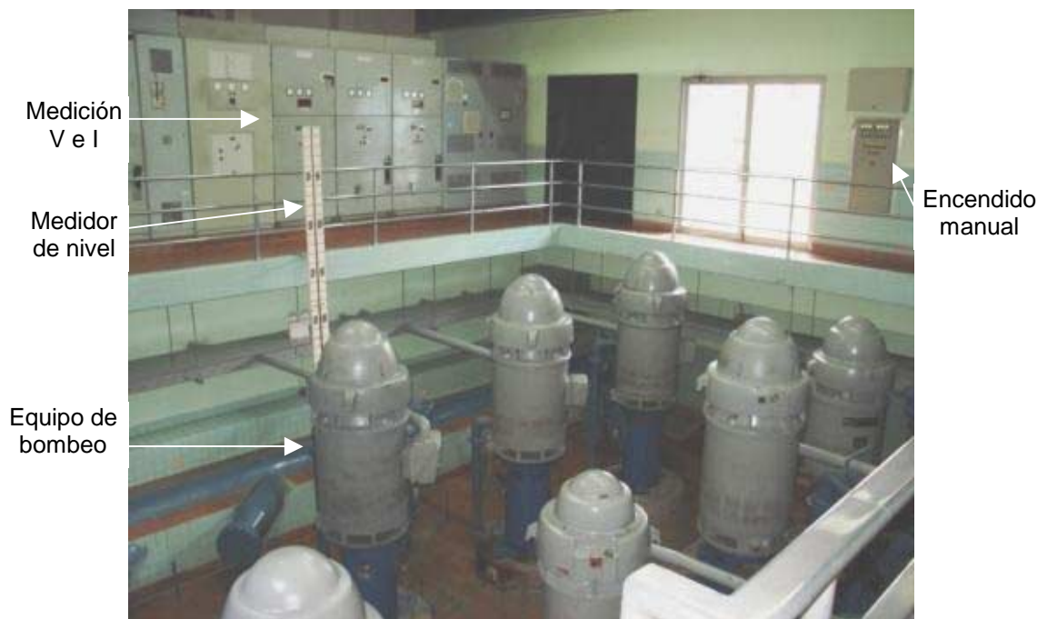
Figura A.4.6 Bombeo y control del bombeo
