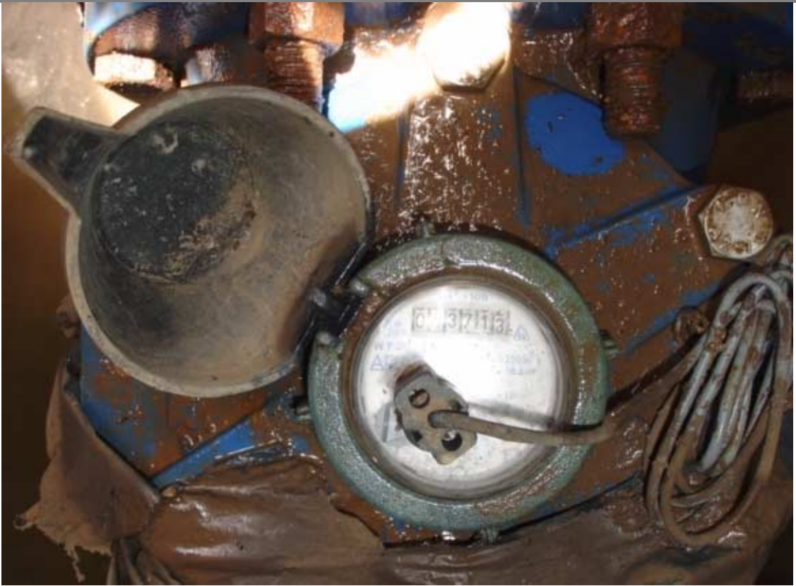
Figura A.4.26 Medidor de caudal mecánico con salida digital.
