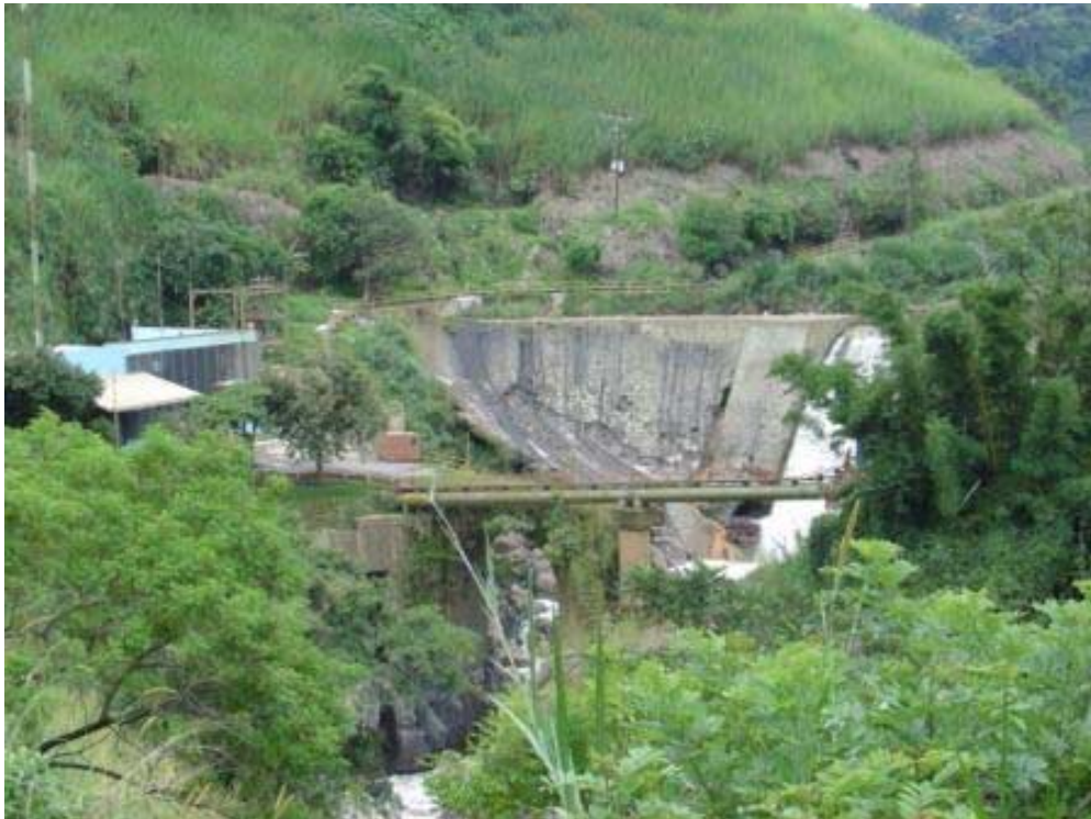
Figura A.4.5 Estación de bombeo Puente de Mulas
