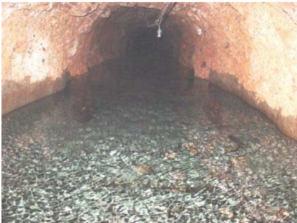
Figura A.4.10 Túnel del pozo de filtración de agua.
