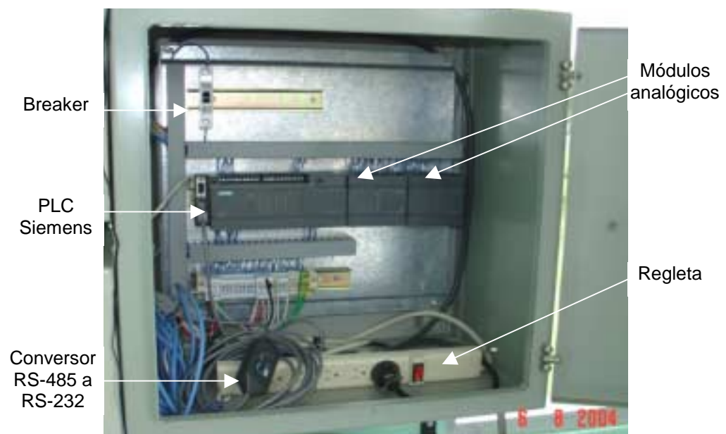
Editor de imágenes de Word Figura 3.1.5.2 Gabinete con PLC.
