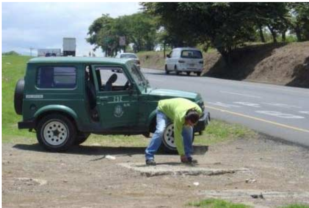
Figura A.4.23 Ingeniero Eduardo Rocha abriendo contenedor del medidor de caudal.
