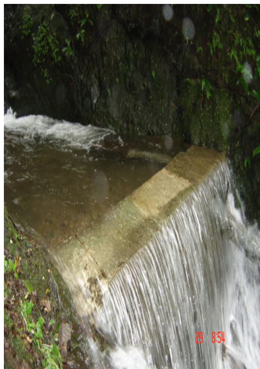
Figura 3: Captación La Veranera
