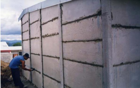
Las paredes internas serán del sistema prefabricado P.C. y se sisaran las juntas únicamente.
