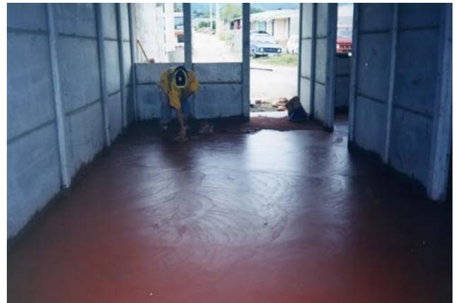
Las paredes exteriores serán del sistema prefabricado P.C, el cual se sisará en todas las juntas y se le aplicará un quemado en todas las paredes externas que queden expuestas.
