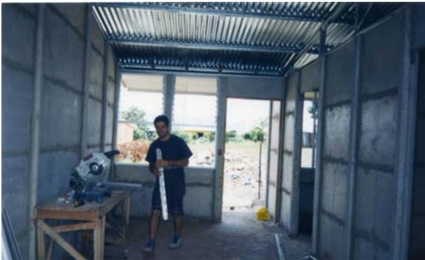
La solera se construirá en con RTG 0-18, atornillado a las columnas prefabricadas, y se colocará sobre todas las paredes y buques de puertas y ventanas.
