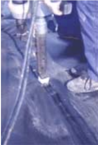
Proceso de soldadura por extrusión en HDPE
