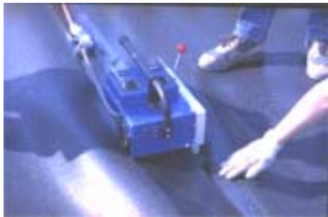
Proceso de soldadura por cuña caliente
