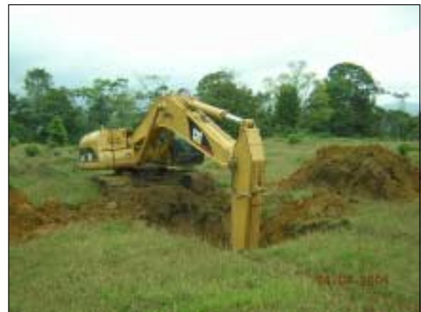
Figura 22. Excavación de G2.
