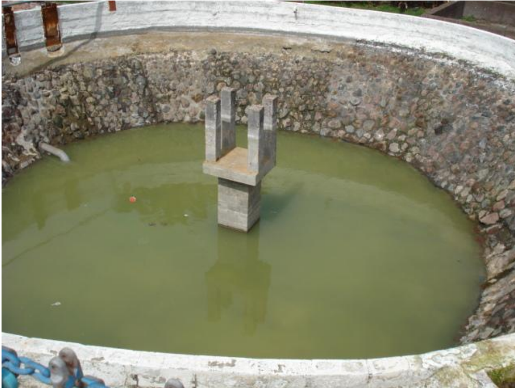
Figura 6-1. Tanque en desuso a utilizar para el proceso de digestión.
