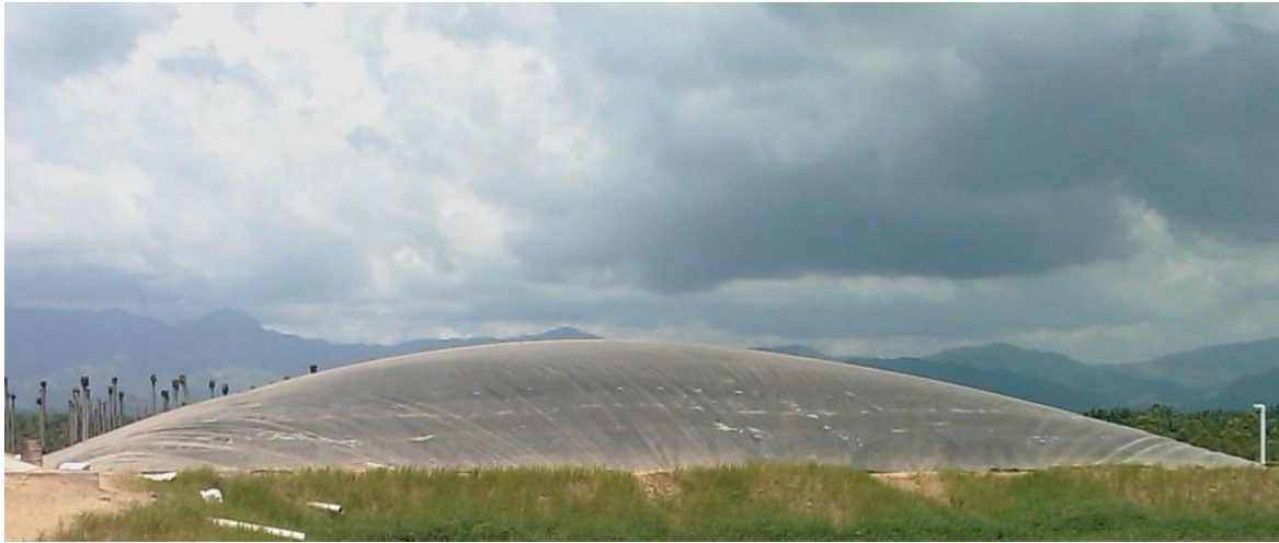
Figura 6-3. Ejemplo de cobertura instalada por AMANCO en una laguna anaerobia (geomembrana de LDPE).
