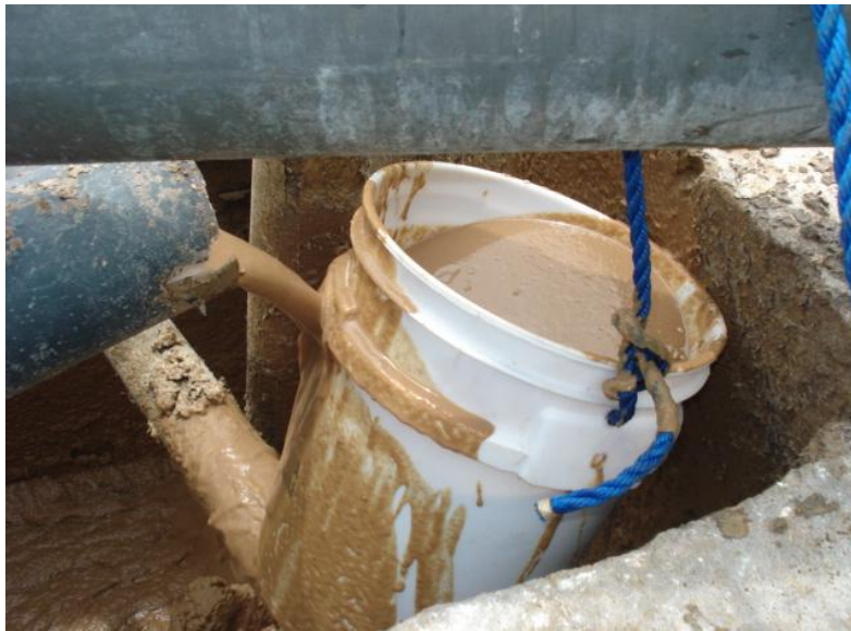
Fotografía 5-1. Extracción de lodo primario previo a la adición de cal.
