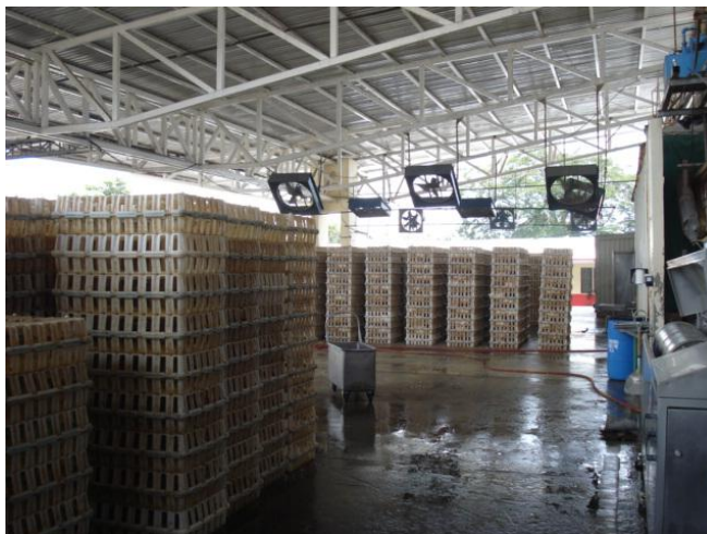
Fotografía 2-1. Andén de recepción de pollo en pie.
