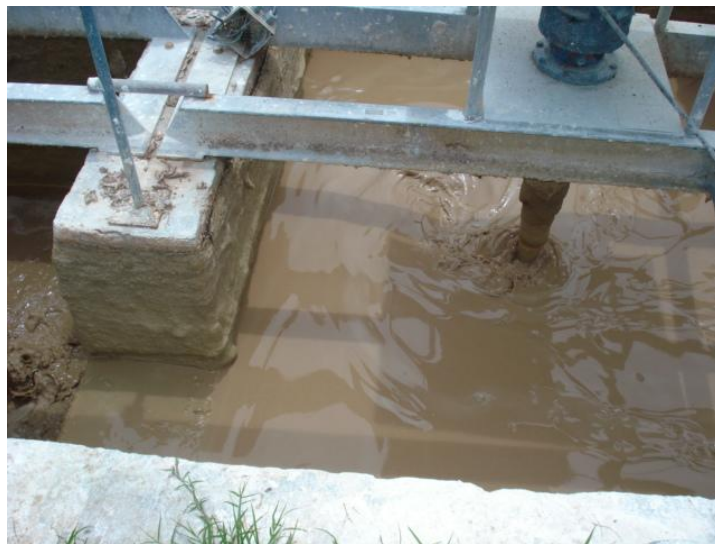
Fotografía 2-8. Lodos primarios durante la mezcla con cal.
