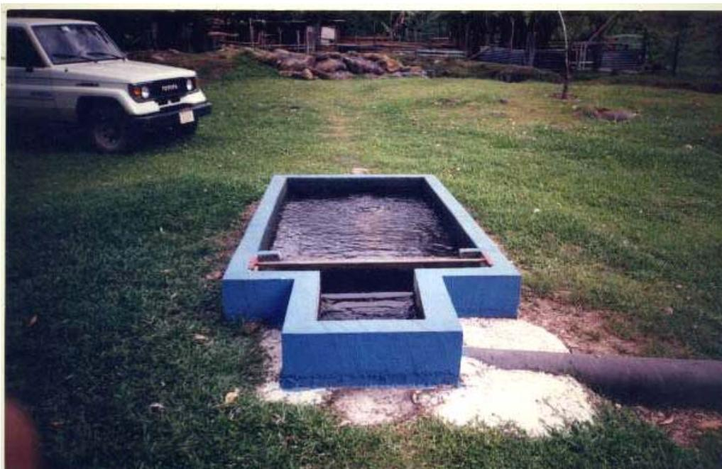
Foto 6. Tanque de sedimentación.
