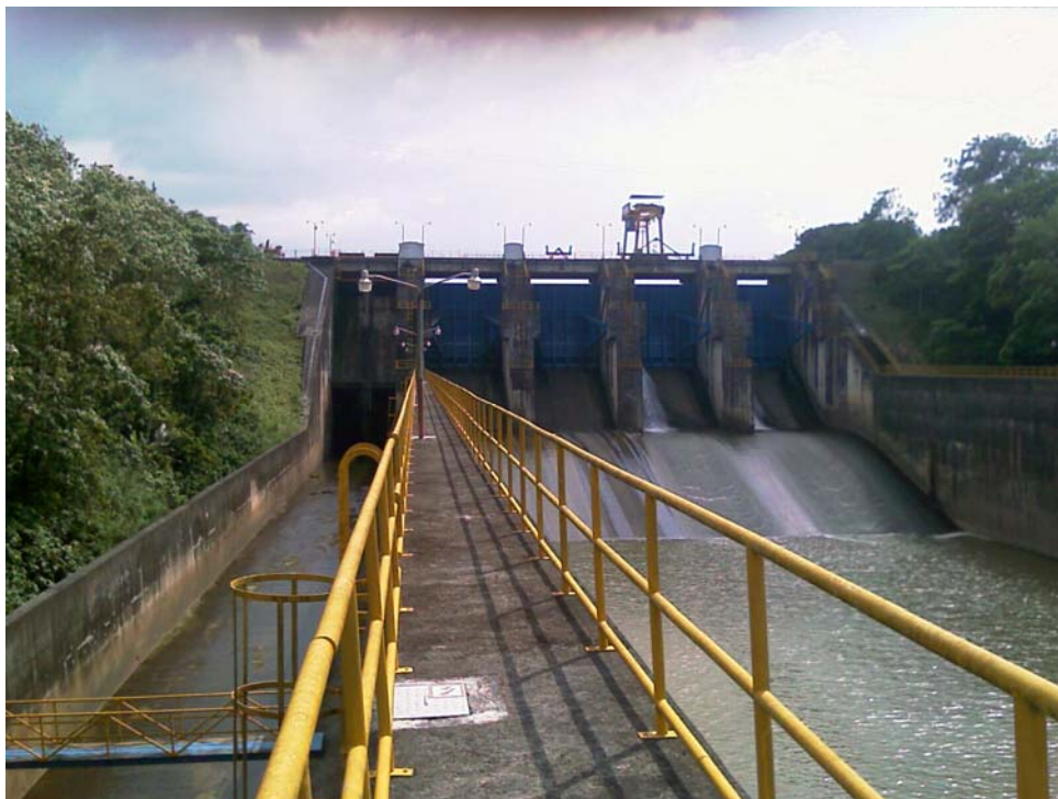
Figura 3.1. Vista general del vertedor de excedencias
