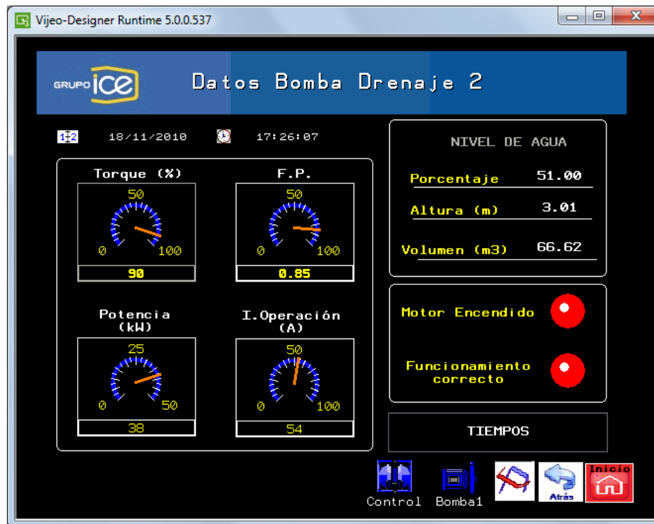
Figura 29. Adquisición de datos en bomba de drenaje 2
