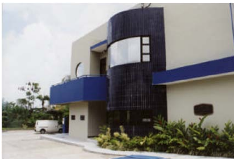
Figura 1.1.1 Edificio de la estación terminal Bribri.
