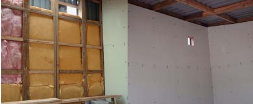
Figura 3-5 Aislamiento de calor. [5]
