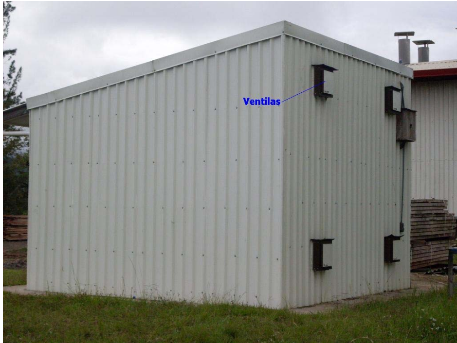
Figura 3-3 Ventiladas de intercambio de aire del secador solar para madera.
