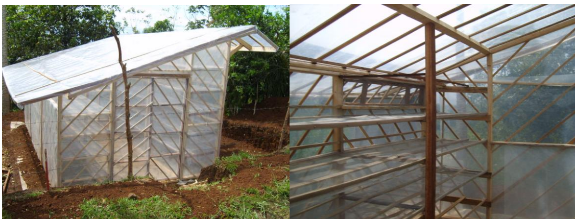
Fig. 1 Construcción de secadores solares
