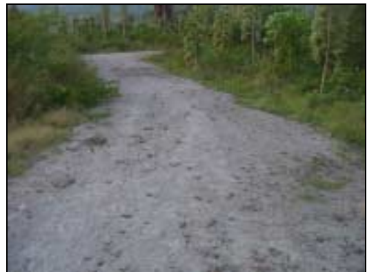
Figura GUA 052-2. Material fino en el tramo de camino entre los puntos 17-21.
