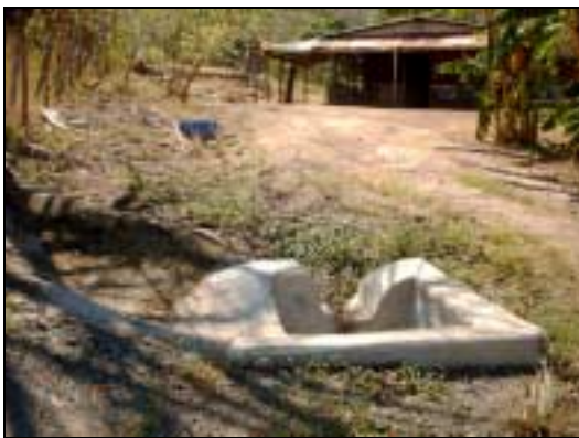
Figura PUN 008-4. Registros sin dispositivo que impida la caída en su interior.
