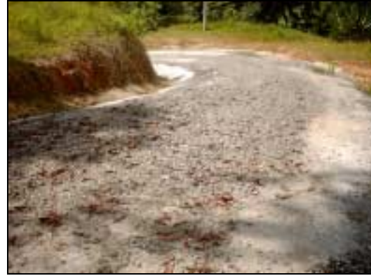
Figura PUN 044-1. Camino con material gravoso en la superficie.
