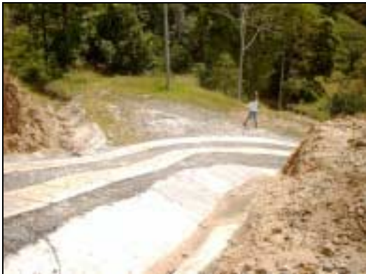
Figura PUN 044-4. Curva cerrada dificulta el ascenso de los vehículos.
