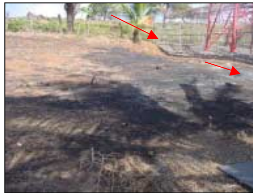
Figura GUA 041-2. Pendiente del terreno con bombeo hacia el interior de la celda.
