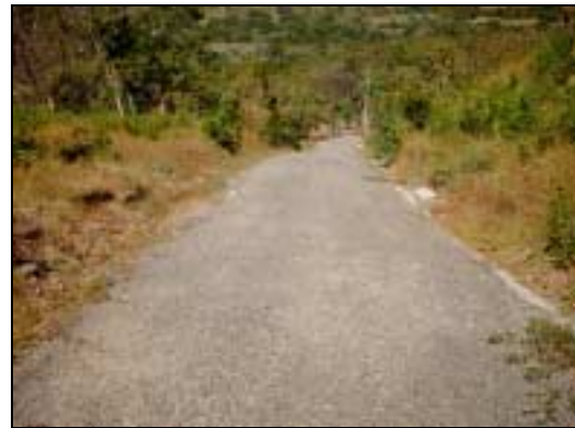
Figura PUN 008-2. Pendiente pronunciada del camino, menor al 25%.
