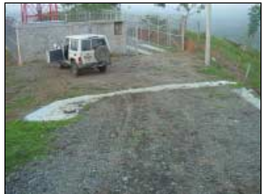
Figura LIM 006-5. Inclinación del terreno con pendiente hacia el interior de la celda.
