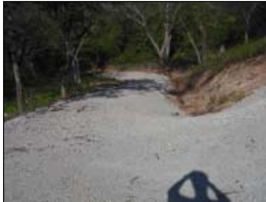
Figura GUA 021-2. Tramo de camino con una cama de piedra suelta.
