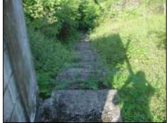
Figura PUN 048-1. Acceso peatonal a la celda.
