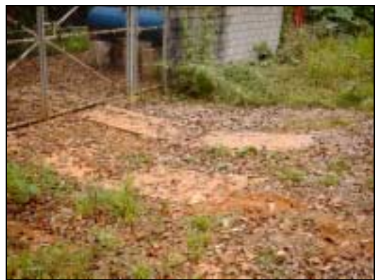
Figura PUN 051-1. Celda sobre la vía pública.
