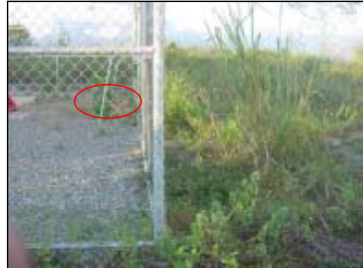
Figura PUN 053-3. Terreno con mayor elevación aledaño a celda.
