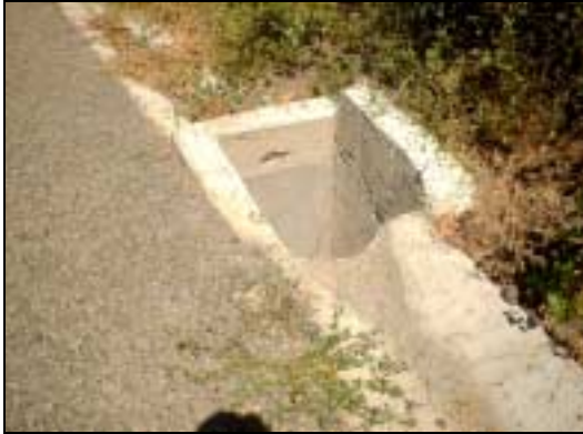
Figura PUN 008-3. Registro sin un elemento que detenga la corriente.
