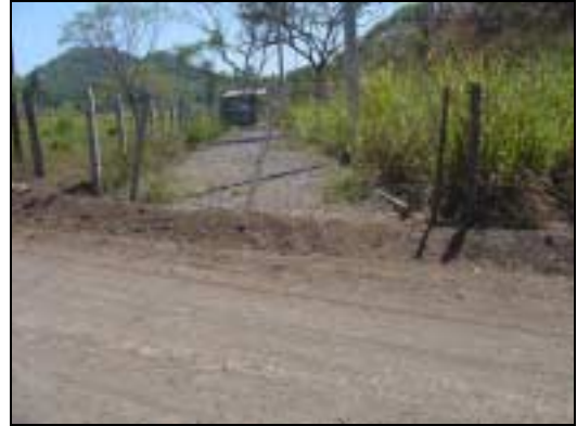
Figura PUN 055-2. Entrada no adecuada.
