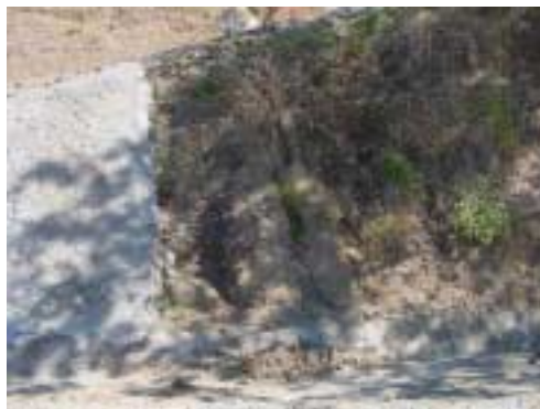
Figura 1. Muestra el tipo de detalles que captan las imágenes correspondientes al registro fotográfico creado como soporte a los aspectos observados.
