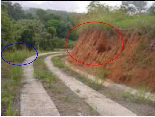
Figura 1. Indica el talud sobre el camino con color rojo y el talud debajo del camino con color azul.
