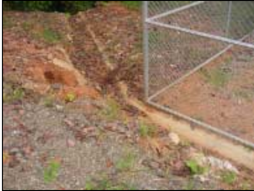
Figura PUN 050-2. Material fino dentro de la celda
