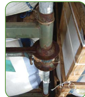
Figura 7. Deterioro contenedores metálicos
