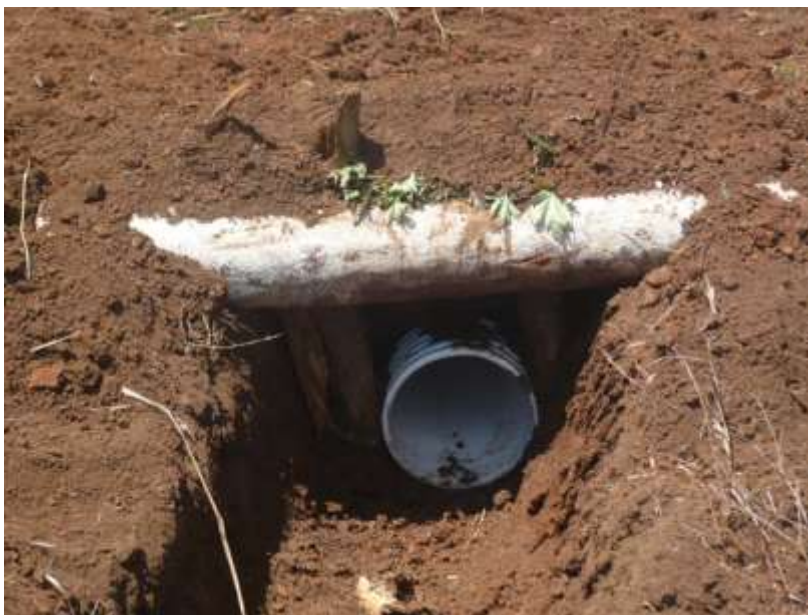
Figura 27. Forma de colocación de alcantarillas en los puntos en el que los drenajes atraviesan los caminos secundarios (Vargas K, 2008).
