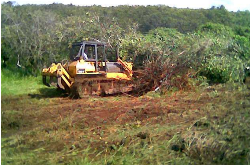
Figura 23. Limpieza o barrida del terreno para iniciar con la preparación del mismo para la siembra de piña en una plantación de naranja con un tractor de orugas tipo D-65. Pocosol de San Carlos (Vargas K, 2007).
