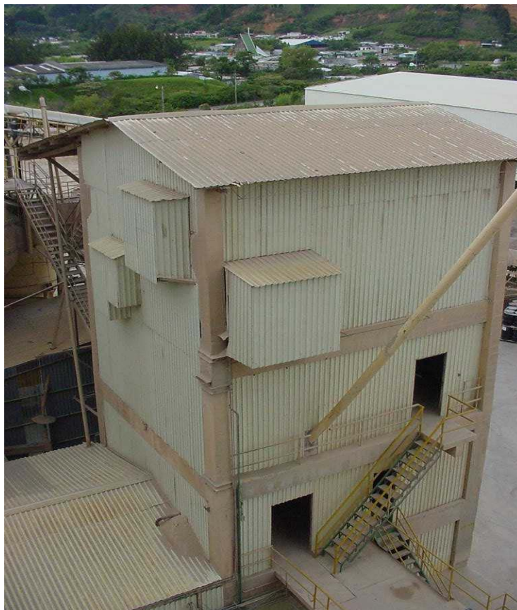
Figura 4.2 Edificio Hazemag, lugar de descarga banda recirculación
