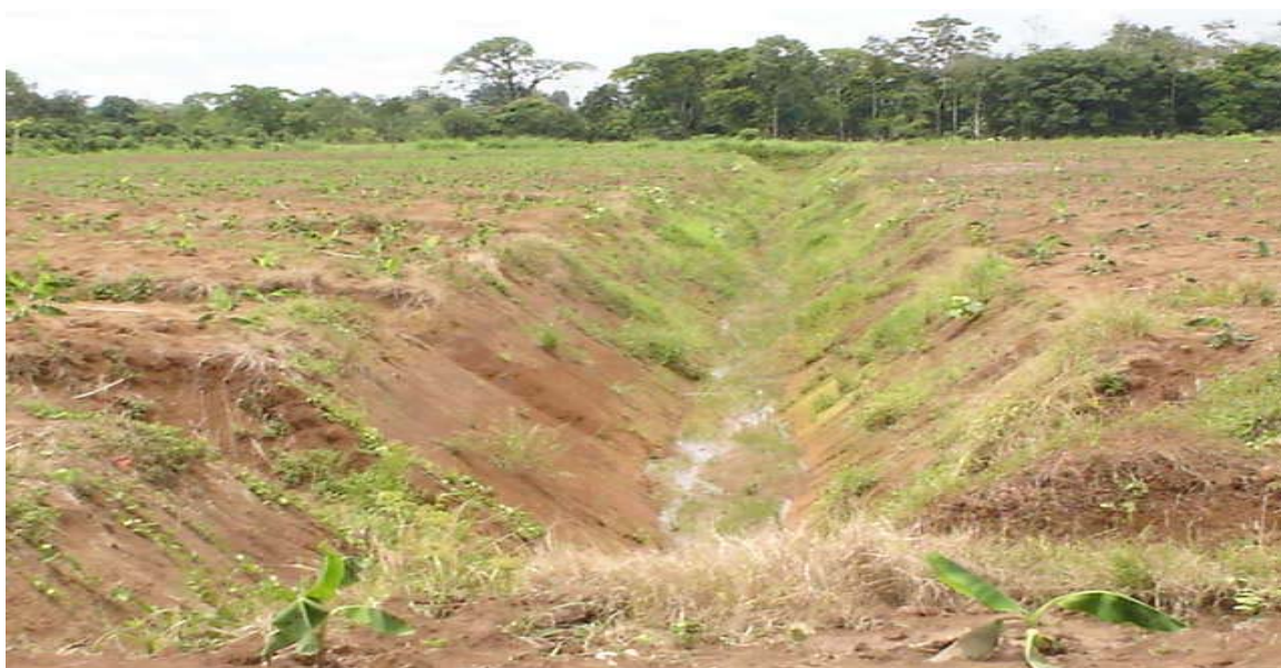
Figura 4. Vista panorámica de un drenaje secundario en el Proyecto de Renovación de finca Triple Tres. 2005.
