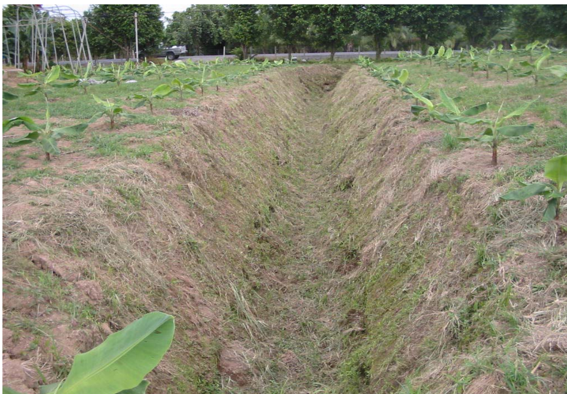
Figura 14. Mantenimiento de la red de drenajes. Chapea en el Proyecto de Renovación, finca Triple Tres 2005.
