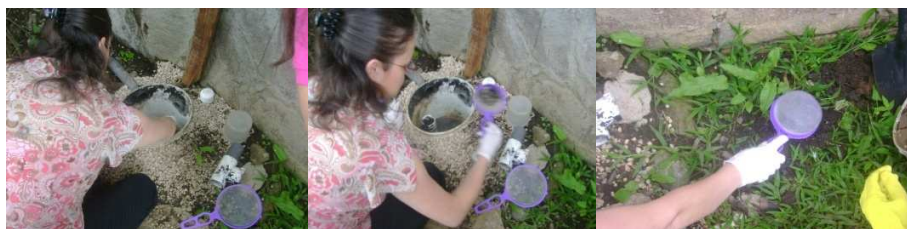
Figura 51. Remoción de sólidos y grasas en pretratamiento de biojardinera de ACEPESA
