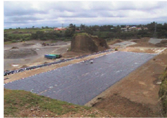
Colocación de la Geomembrana sobre el terreno
