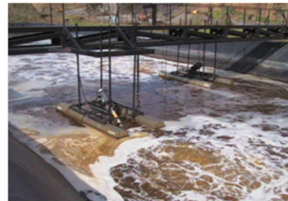
Laguna de oxidación de lixiviados
