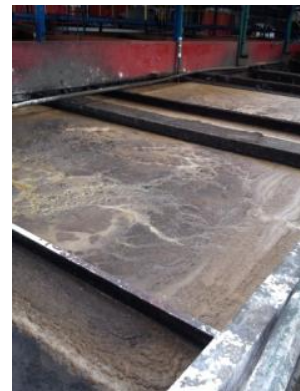
Sedimentador primario en operación. Obsérvese que se le forma una capa como una espuma que no sedimenta.
