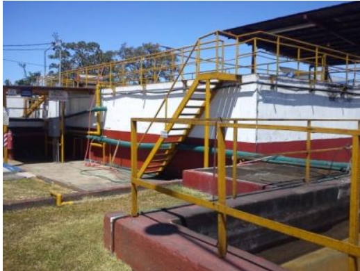
Reactor anaerobio de flujo ascendente
