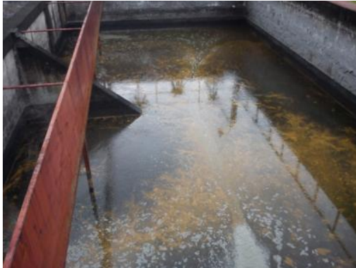
Agua almacenada en el tanque pulmón a mediados del mes de diciembre. Captura 14 de diciembre 2011.
