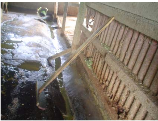
Caños limpios con poca boñiga y agua..
