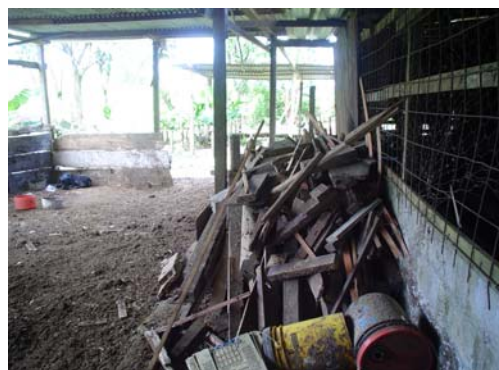
Escombros dentro del galerón
