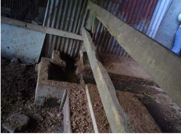
Caños de desagüe aguas de lavado y pileta que retiene agua residual
