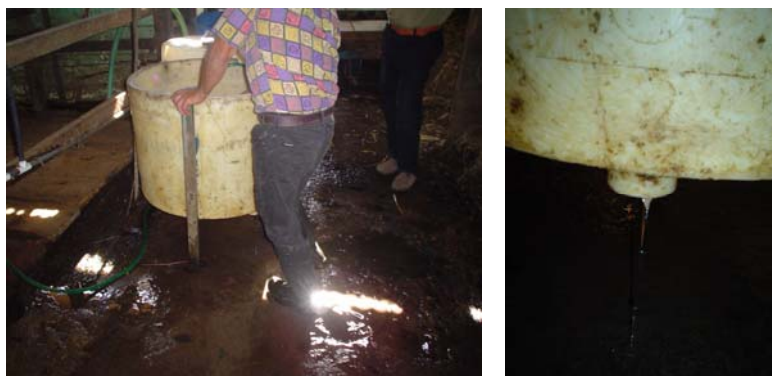
Tanque de almacenamiento de agua
