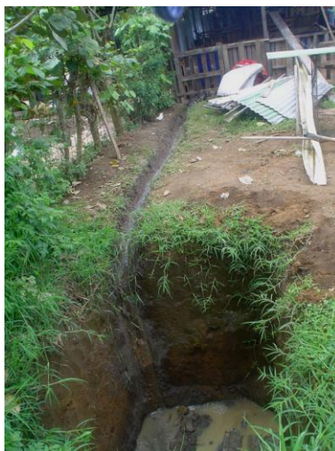
Figura 22. Fosa para recibir los desechos sólidos y líquidos del proceso de lavado de la porqueriza.
