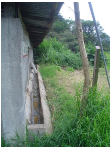
Figura 17. Canales de desagüe de cemento.
