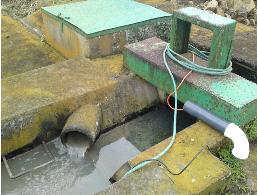
Figura 5. Caja de registro de la cual se bombeó el agua residual para la alimentación del sistema experimental.
