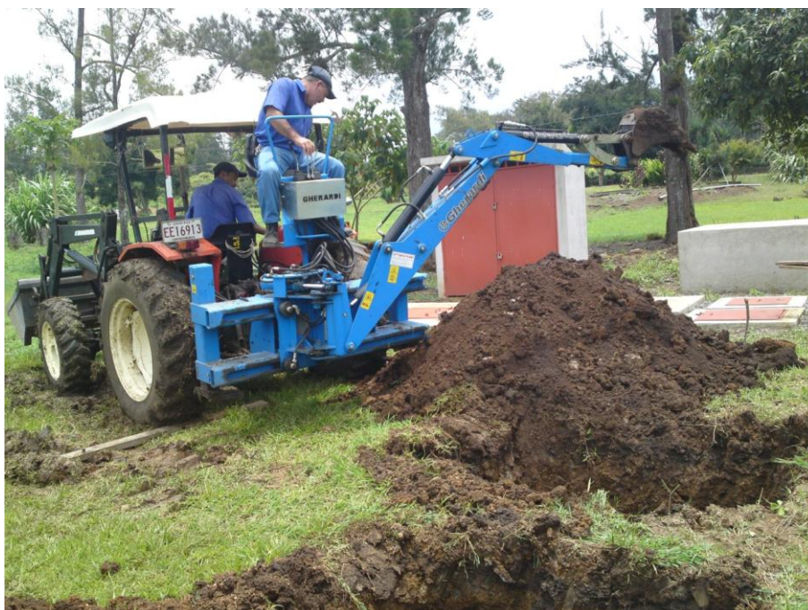
Figura 2. Excavación de huecos para la instalación del sistema experimental.
