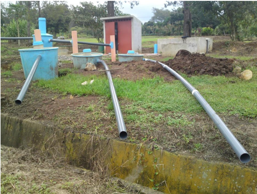
Figura 6. Salida de efluentes de los tres FAFAs hacia el canal de salida de las lagunas.
