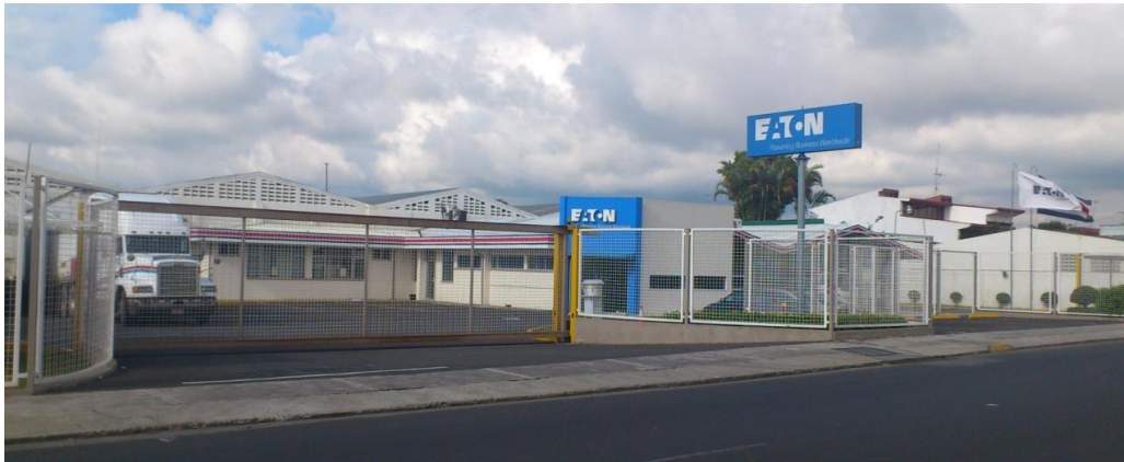
Figura 5. Instalaciones de Eaton Electrical S.A. en Moravia, Costa Rica.
