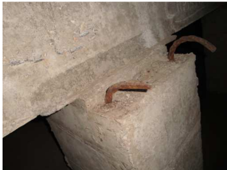
Figura 51. Varillas de columna en sótano norte
