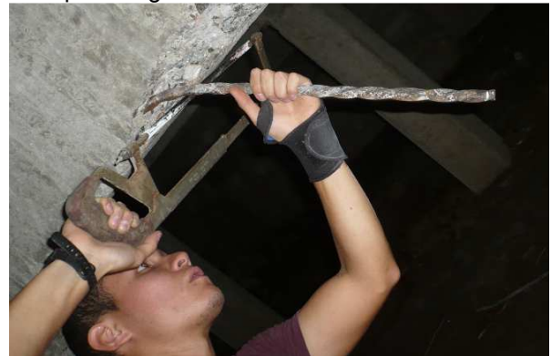
Figura 21. Corte de varilla para la extracción de acero
