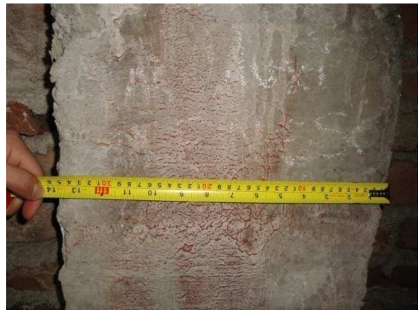
Figura 26. Medición de columna de concreto reforzado
