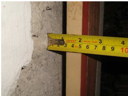
Figura 50. Repello de columna en sótano oeste
