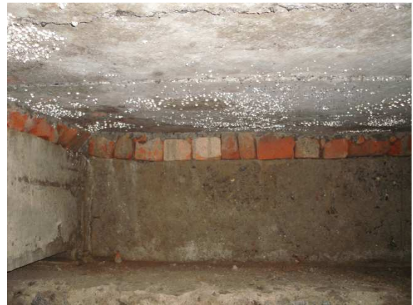
Figura 52. Entrepiso sobre viga de entrepiso apoyado en el muro de contención
