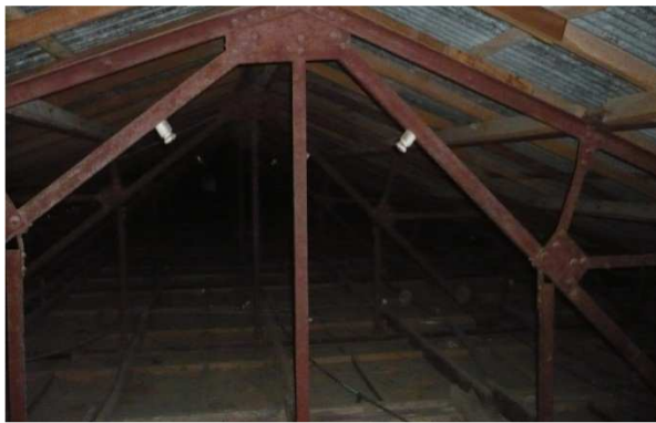
Figura 14. Cercha estructura Metálica
