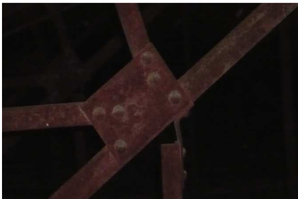
Figura 15. Unión de elementos de metal.
