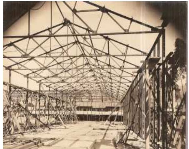
Figura 12. Estructura de techo (Armazón).
