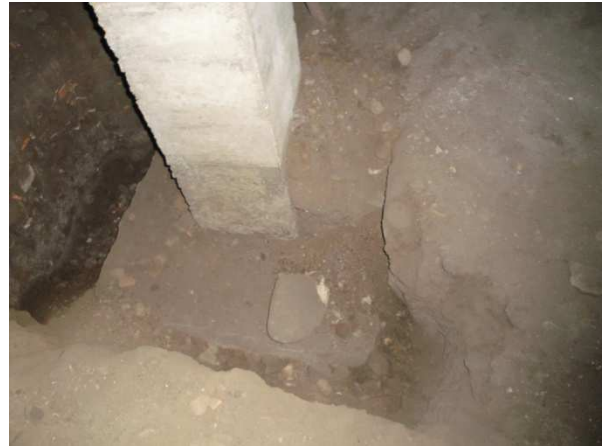
Figura 47. Placa aislada descubierta
