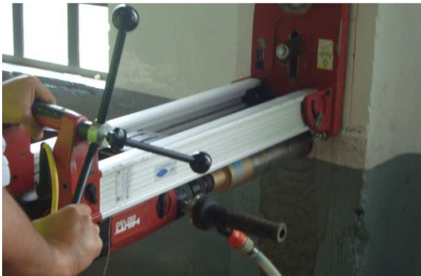
Figura 19. Extracción de Núcleo a columna del sector sur del edificio.
