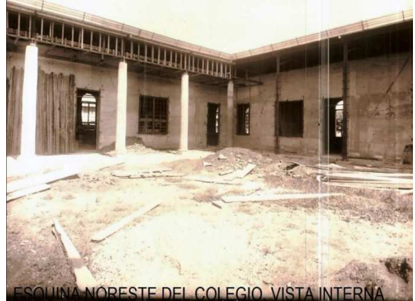
Figura 11. Estructura de acero de los muros
