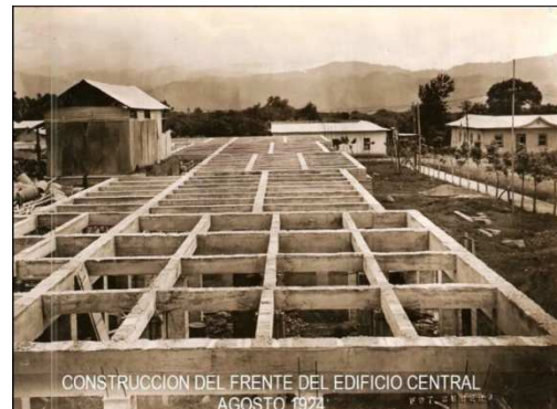
Vigas de entepiso del sector oeste del edificio
