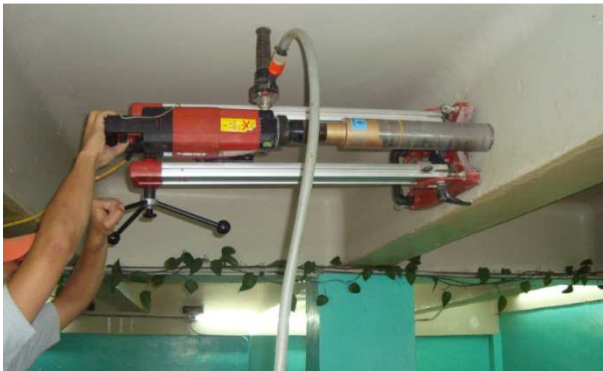
Figura 18. Extracción de Núcleo a viga de entrepiso, ubicada en el comedor del edificio.
