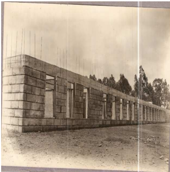
Figura 6. Vista fachada sur del Colegio de San Luis Gonzaga.
