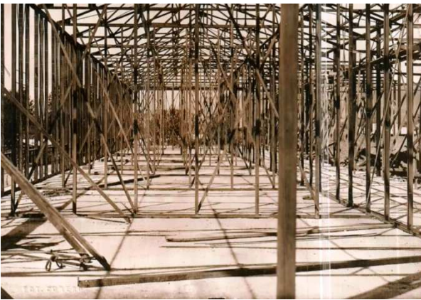
Figura 10. Estructura de acero de los muros
