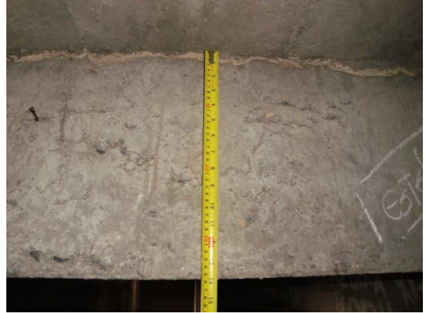
Figura 25. Medición de viga de concreto reforzado
