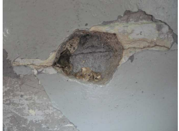
Figura 61. Profundidad de agrietamientos
