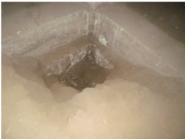
Figura 46. Placa corrida descubierta
