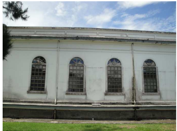
Figura 48. Vista de la fachada norte
