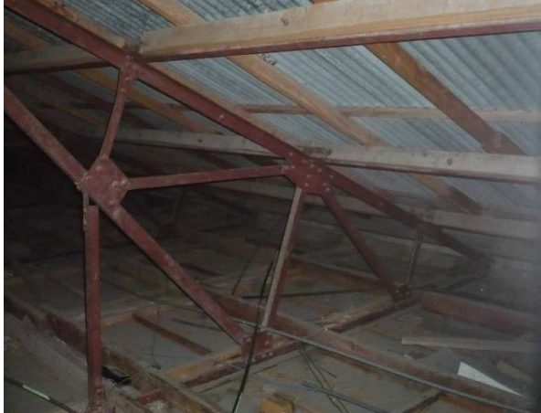
Figura 13. Cercha, Estructura Metálica
