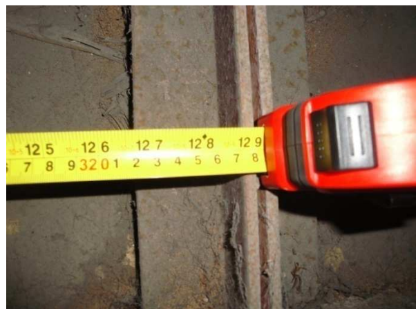
Figura 27. Medición de angular de cuerda inferior de cerchas
