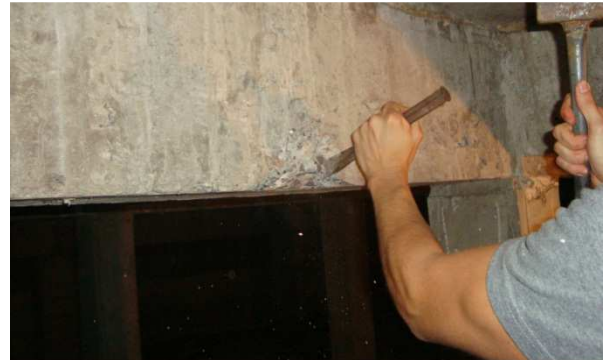
Figura 20. Extracción de acero en una viga de entrepiso longitudinal.
