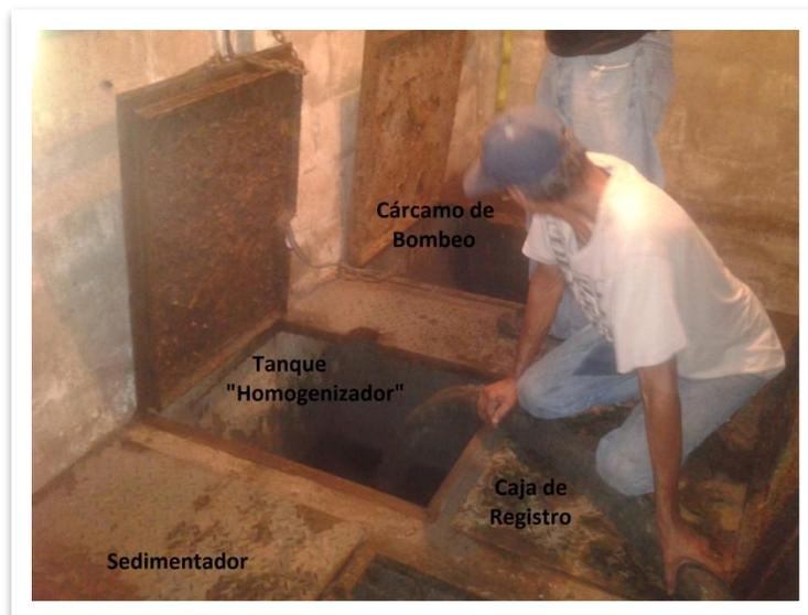
**Figura 7.** Etapas posteriores al tanque de aireación.
