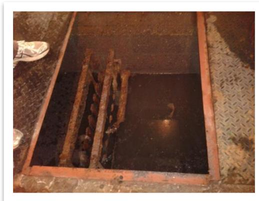
**Figura 6.** Sedimentador secundario del sistema de tratamiento del Condominio.
