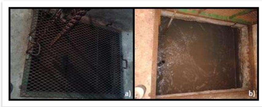
**Figura 5.** Tratamiento biológico secundario del sistema de tratamiento del Condominio: (a) compuerta cerrada, (b) compuerta abierta.
