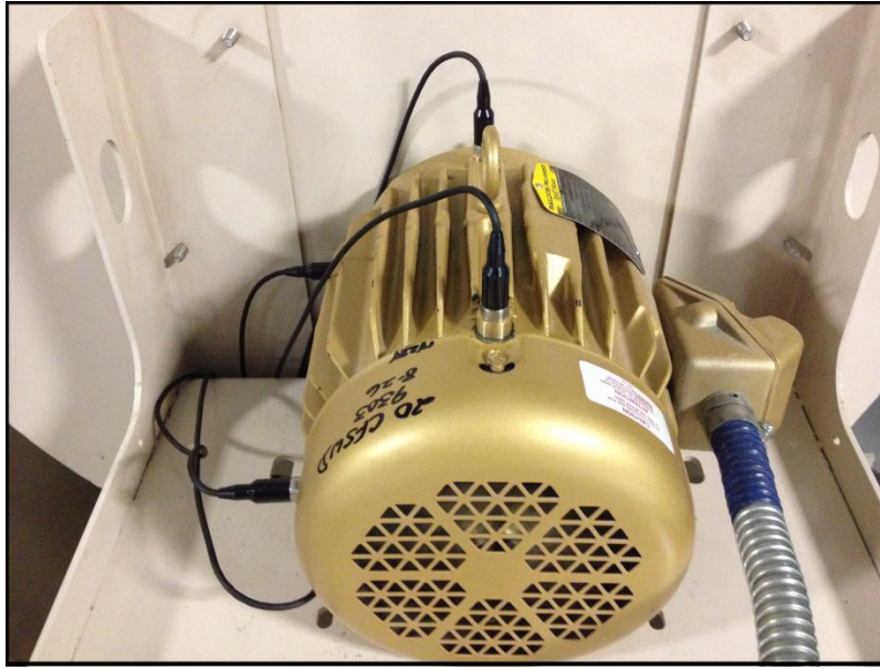
Figura 5.6 Montaje de sensores de vibración 608A11.
