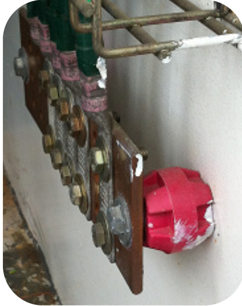
Figura 28. Aislador tipo granada para barra de tierras.
