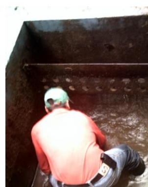
Figuras A.7.72 a A.7.76. Limpieza del desarenador.
