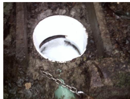
Figuras A.7.6 a A.7.9. Captación de la naciente y barrera de seguridad.
