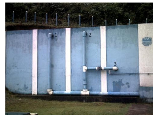
Figuras A.7.35 y A.7.36. Salidas del caudal de rebose (1 y 2), Salida superficial para la limpieza (3).
