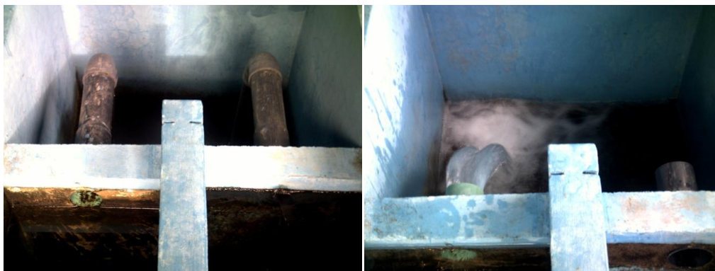
Figuras A.7.54 y A.7.55. Cambio en la tubería de las canaletas colectoras de agua filtrada.
