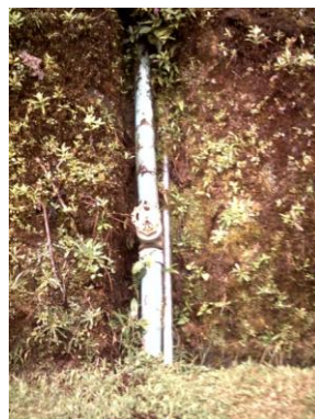
Figuras A.7.20 y A.7.21. Tubería de caudal de entrada a la planta y válvula de regulación manual de caudal y detalle de la figura anterior: tubería izquierda gris transporta el caudal de alimentación del sistema de medición de turbiedad, tubería central de alimentación principal, tubería plateada derecha alimenta el área de lavado de arena.
