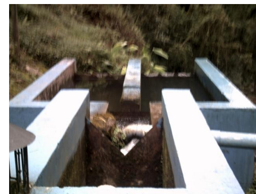
Figuras A.7.10 a A.7.12. Puente hacia los desarenadores; alrededores de los desarenadores (río a la der) y Cámara de entrada y zonas de sedimentación paralelas.
