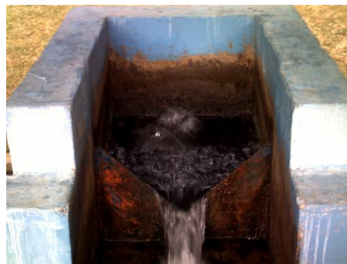
Figura A.7.30. Cámara de entrada y vertedero.
