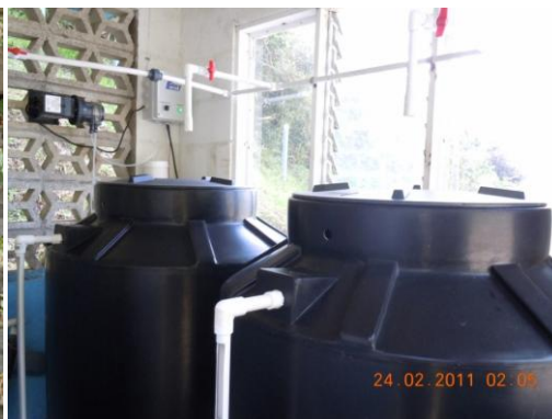
Figuras A.7.60 a A.7.62. Panel de control del nuevo sistema de cloración in situ Easy Clor; tanques nuevos para la preparación de disolución de cloro; y sistema de tuberías de salida y punto de dosificación en el tanque de cloración.
