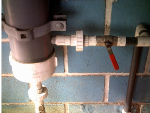
Figura A.7.22. Entrada del agua al sifón.
