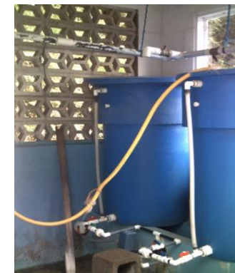
Figura A.7.40 Casetilla de cloración y tanque de contacto. Figuras A.7.41 a A.7.43. Panel de control de cloración por electrólisis, electrodo y estañones con disolución de cloro.
