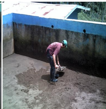
Figuras A.7.85 a A.7.89. Proceso de limpieza de los FLA: filtro en proceso de vaciado; remoción de la capa biológica; rearenado, distribución de la arena y emparejado de la superficie del FLA.
