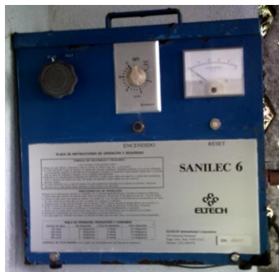
Figura A.7.40 Casetilla de cloración y tanque de contacto. Figuras A.7.41 a A.7.43. Panel de control de cloración por electrólisis, electrodo y estañones con disolución de cloro.
