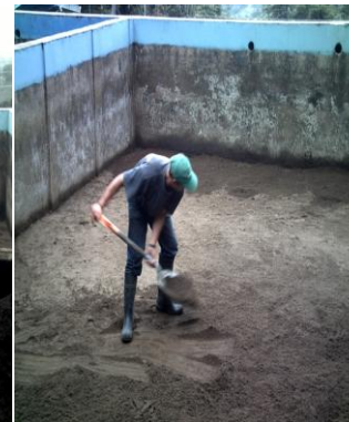
Figuras A.7.85 a A.7.89. Proceso de limpieza de los FLA: filtro en proceso de vaciado; remoción de la capa biológica; rearenado, distribución de la arena y emparejado de la superficie del FLA.
