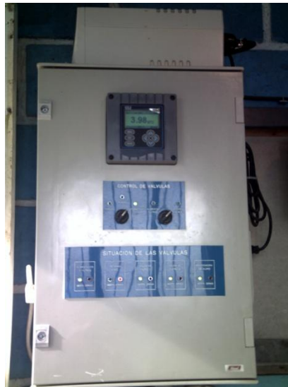
Figuras A.7.24 y A.7.25. Panel de control del sistema de entrada del caudal a la planta y batería de suministro eléctrico.
