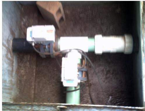
Figuras A.7.26 a A.7.28. Pantalla digital de la lectura de turbiedad; válvula automática de control de alimentación a la planta y control del modo de operación y de las válvulas automáticas.
