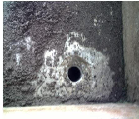
Figuras A.7.81 y A.7.82. Desagüe y musgo en el área de lavado de arena.
