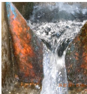
Figuras A.7.77 a A.7.80. Crecimiento de algas y biopelículas sobre el vertedero y en las cámaras de entrada de fluido a la planta y a los FLA.
