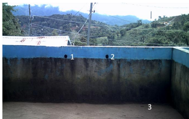
Figuras A.7.35 y A.7.36. Salidas del caudal de rebose (1 y 2), Salida superficial para la limpieza (3).
