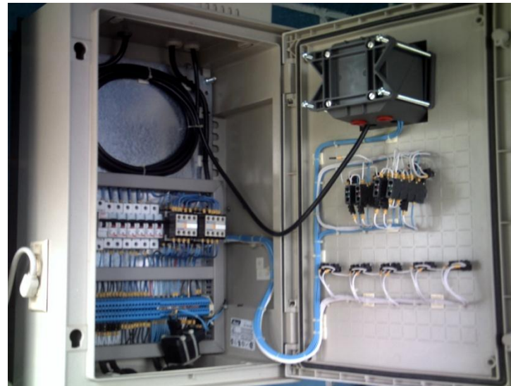
Figuras A.7.24 y A.7.25. Panel de control del sistema de entrada del caudal a la planta y batería de suministro eléctrico.
