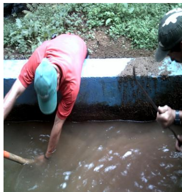
Figuras A.7.72 a A.7.76. Limpieza del desarenador.
