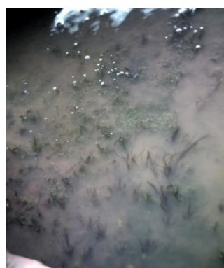
Figuras A.7.77 a A.7.80. Crecimiento de algas y biopelículas sobre el vertedero y en las cámaras de entrada de fluido a la planta y a los FLA.
