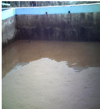
Figuras A.7.85 a A.7.89. Proceso de limpieza de los FLA: filtro en proceso de vaciado; remoción de la capa biológica; rearenado, distribución de la arena y emparejado de la superficie del FLA.
