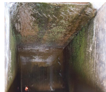
Figuras A.7.77 a A.7.80. Crecimiento de algas y biopelículas sobre el vertedero y en las cámaras de entrada de fluido a la planta y a los FLA.
