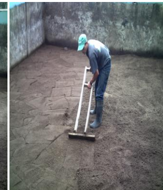
Figuras A.7.85 a A.7.89. Proceso de limpieza de los FLA: filtro en proceso de vaciado; remoción de la capa biológica; rearenado, distribución de la arena y emparejado de la superficie del FLA.
