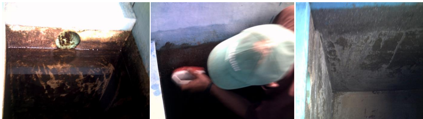
Figura A.7.90. Biofilm sobre las paredes de la canaleta. Figura A.7.91. Lavado de la canaleta colectora de agua filtrada. Figura A.7.92. Canaleta limpia.
