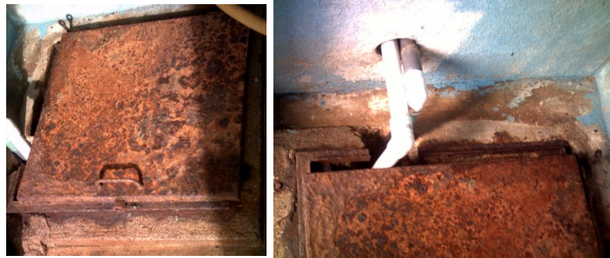
Figura A.7.47. Tapa del acceso al tanque de cloración y detalle.
