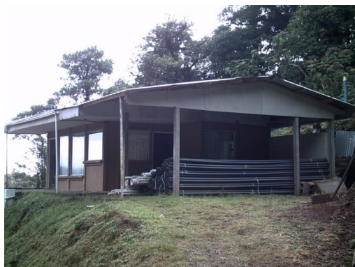
Figura A.7.52. Casa de reuniones y bodega.
