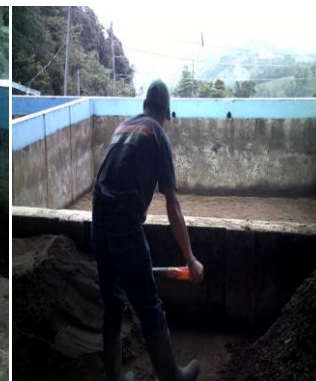
Figuras A.7.85 a A.7.89. Proceso de limpieza de los FLA: filtro en proceso de vaciado; remoción de la capa biológica; rearenado, distribución de la arena y emparejado de la superficie del FLA.
