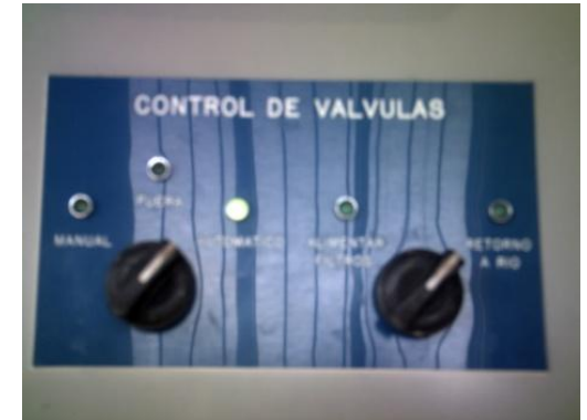
Figuras A.7.26 a A.7.28. Pantalla digital de la lectura de turbiedad; válvula automática de control de alimentación a la planta y control del modo de operación y de las válvulas automáticas.
