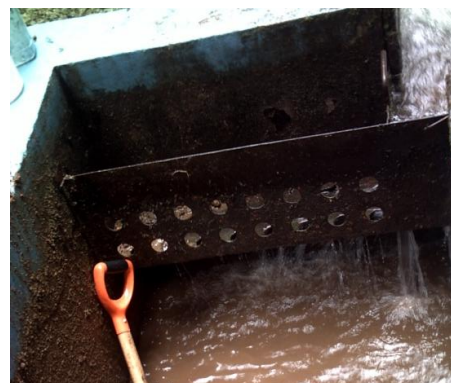
Figura A.7.13. Tubería original (izq) y tubería actual (der). Figura A.7.14. Rejillas en las zonas de sedimentación. Figura A.7.15. Compuerta de desarenadores.
