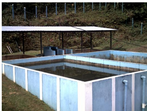
Figura A.7.35. Sistema paralelo de filtración lenta.
