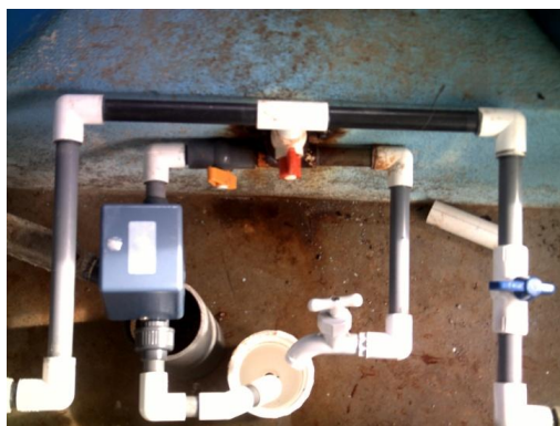
Figura A.7.44. Sistema de dosificación de cloro. Figura A.7.45. Instalación eléctrica en la casetilla de cloración. Figura A.7.46. Afluente del tanque de contacto.
