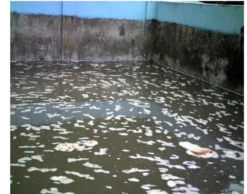
Figura A.7.83. Sistema en paro por alta turbiedad. Figura A.7.84. Material sobrenadante.
