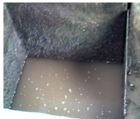
Figuras A.7.77 a A.7.80. Crecimiento de algas y biopelículas sobre el vertedero y en las cámaras de entrada de fluido a la planta y a los FLA.
