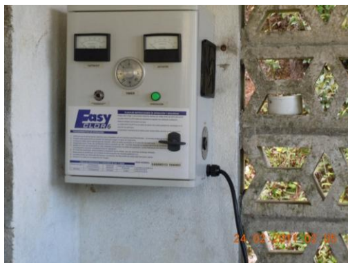
Figuras A.7.60 a A.7.62. Panel de control del nuevo sistema de cloración in situ Easy Clor; tanques nuevos para la preparación de disolución de cloro; y sistema de tuberías de salida y punto de dosificación en el tanque de cloración.
