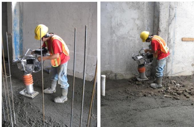
**Ilustración 4: Operación del brincón 1 en tierra arenosa y grava con cemento respectivamente**
