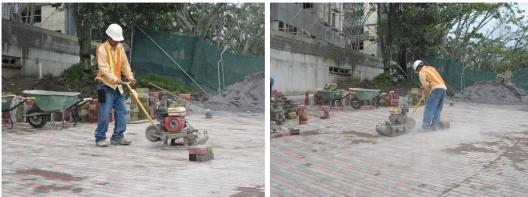
Ilustración 8: Uso de la planadora de adoquines
