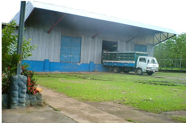
Figura 6.- Instalaciones de la Planta Empacadora La Perla
