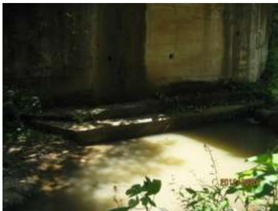
Figura 1. Cimiento del Bastión de Salida
