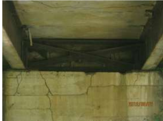
Figura 6 Apoyo de Losa en el bastión de Salida
