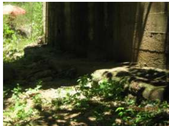
Figura 2. Cimiento actual Bastión de Ingreso
