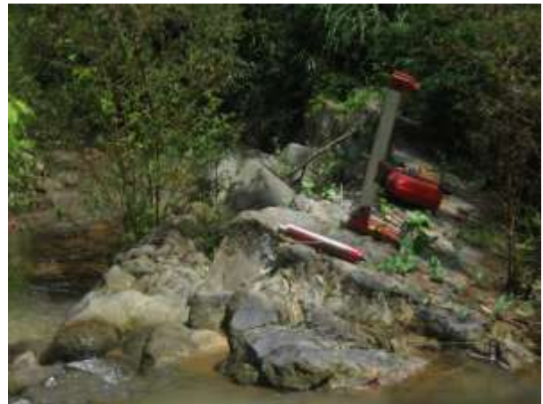
Figura 46. Zona de perforaciones, Aguas Arriba, Margen Izquierdo
