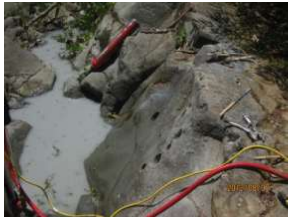
Figura 44. Zona de perforaciones, Aguas Arriba, Margen Derecho
