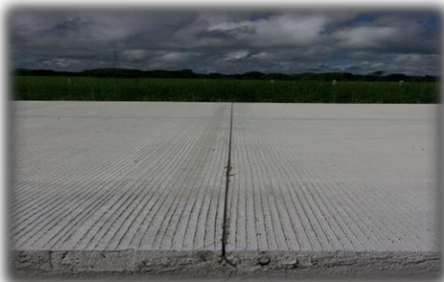
Imagen 22. Junta transversal correctamente aserrada y sellada.
