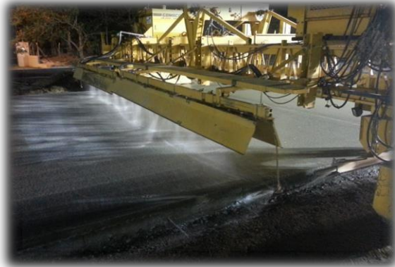
Imagen 18. Aplicación de la membrana de curado.
