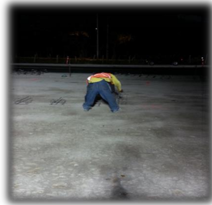
Imagen 10. Fijación de los pasadores de carga en la junta longitudinal.
