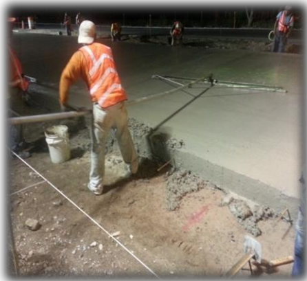
Imagen 14. Flotado manual de la superficie del concreto.
