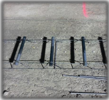
Imagen 8. Dovelas engrasadas en la canasta de soporte.
