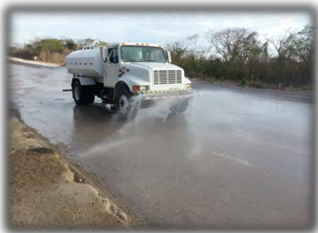
Imagen 6. Cisterna utilizada para el humedecimiento superficial de la base estabilizada.
