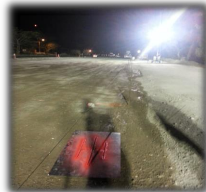
Imagen 7. Línea de guía para la extendidora de concreto.
