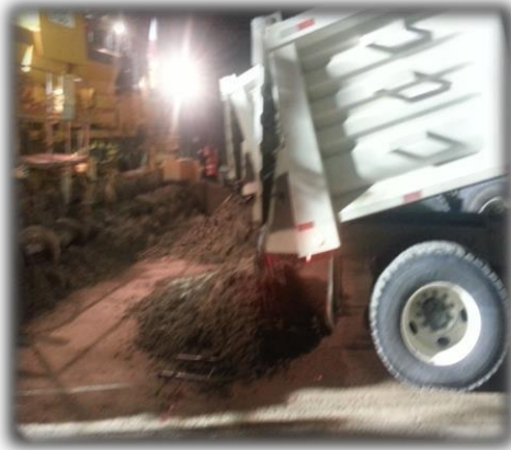
Imagen 12. Descarga simultánea del concreto en ambos carriles.
