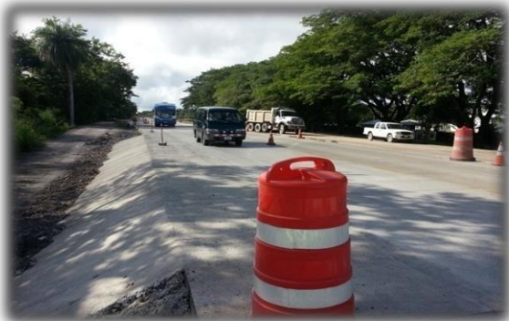
Imagen 21. Tramo abierto al tránsito.
