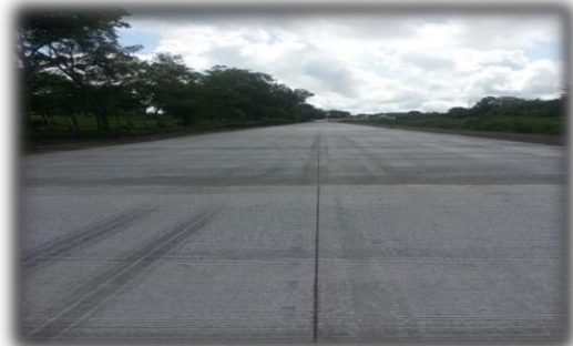
Imagen 24. Junta longitudinal sellada.
