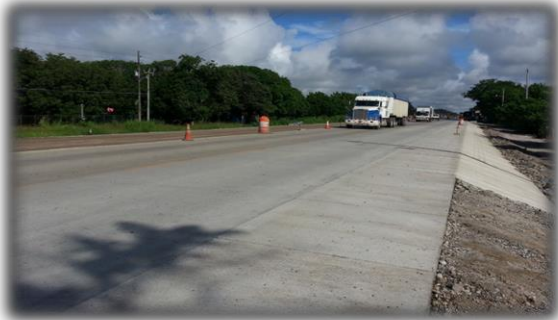
Imagen 20. Tramo abierto al tránsito desde la estación 210+819,25 hasta la 208+328 (aproximadamente 2,5 km).
