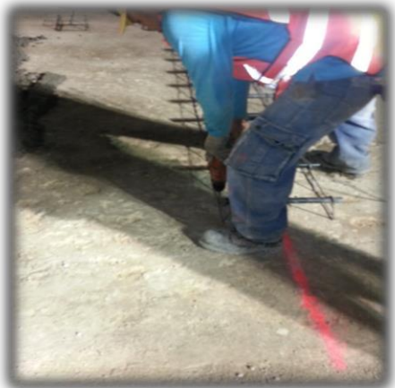
Imagen 9. Fijación de los pasadores de carga en la junta transversal.
