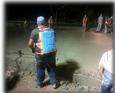
Imagen 17. Aplicación del reductor de evaporación.
