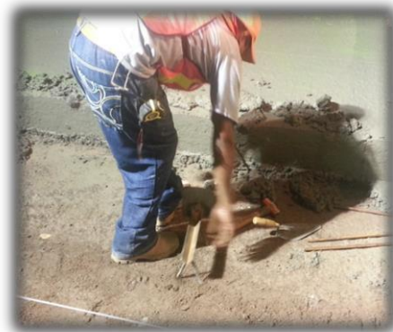
Imagen 11. Fijación de pasadores de carga a los costados de las losas.
