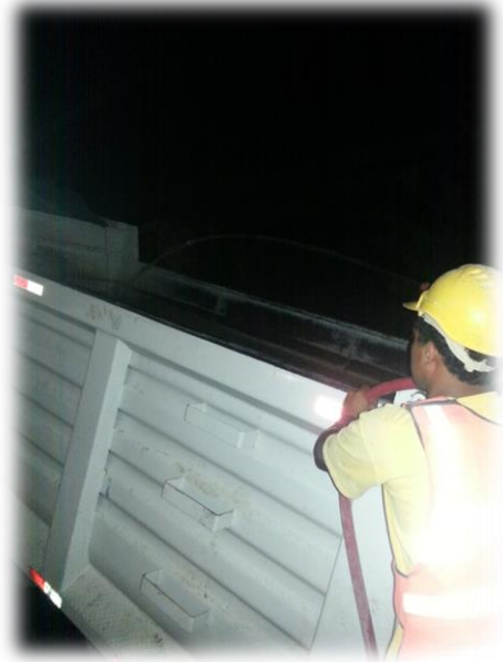
Imagen 4. Lavado del recipiente del camión transportador de concreto.
