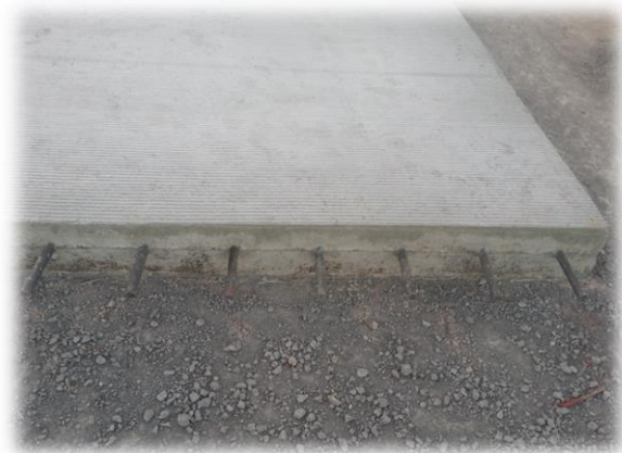
Imagen 11. Junta de construcción finalizada.
