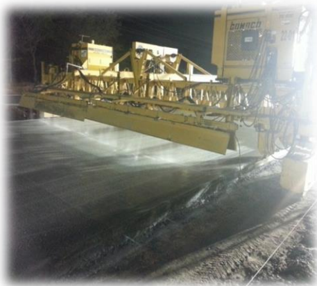
Imagen 15. Máquina Gomaco TC 400 aplicando la membrana de curado.
