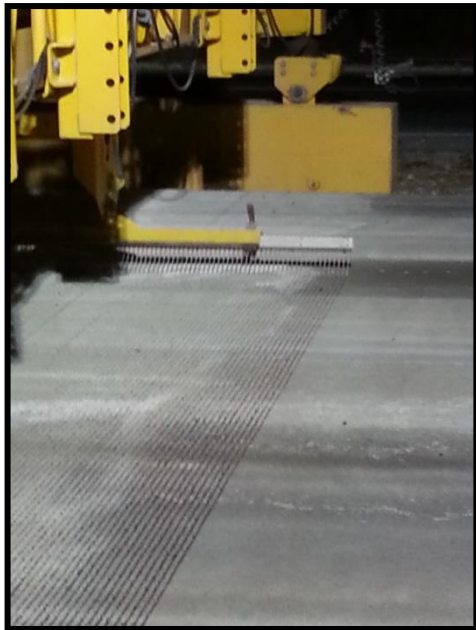
Imagen 13. Texturizado con la máquina Gomaco TC 400.
