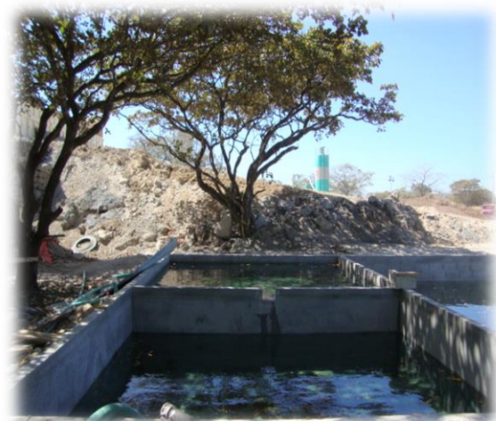
Imagen 2. Reservorio de agua utilizado en el proyecto Cañas-Liberia.
