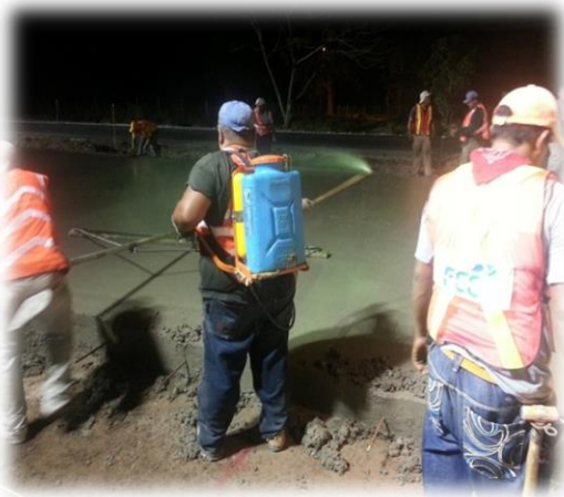
Imagen 14. Aplicación del anti evaporador con bomba manual.
