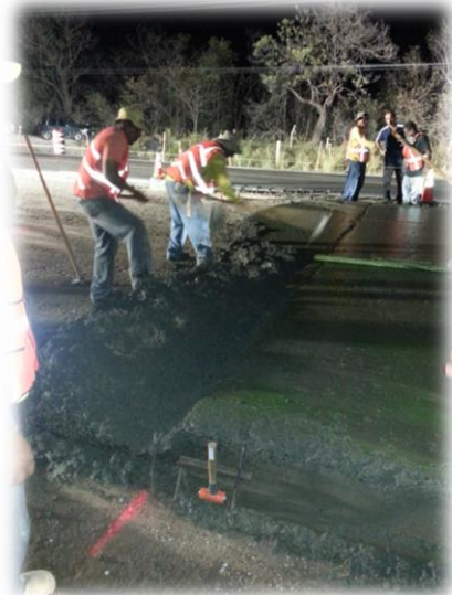
Imagen 10. Realización de una junta de construcción
