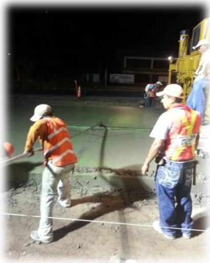
Imagen 12. Proceso de allanado de la superficie de la losa.
