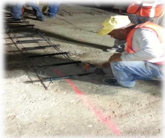
Imagen 8. Fijación de las canastas de dovelas en la marca colocada previamente por topografía.
