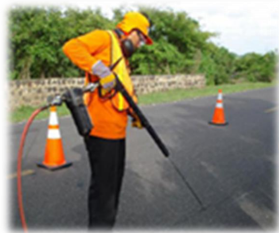
Imagen 19. Sellado de junta longitudinal.
