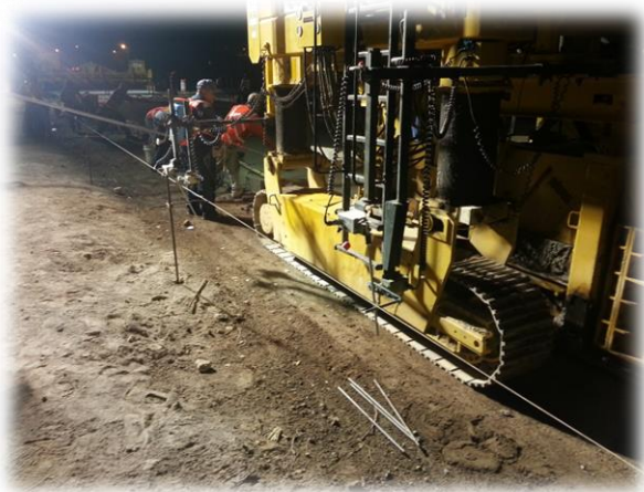
Imagen 7. Sensores de la máquina pavimentadora apoyados sobre las líneas guía.
