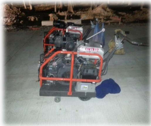
Imagen 17. Máquinas para corte del concreto.
