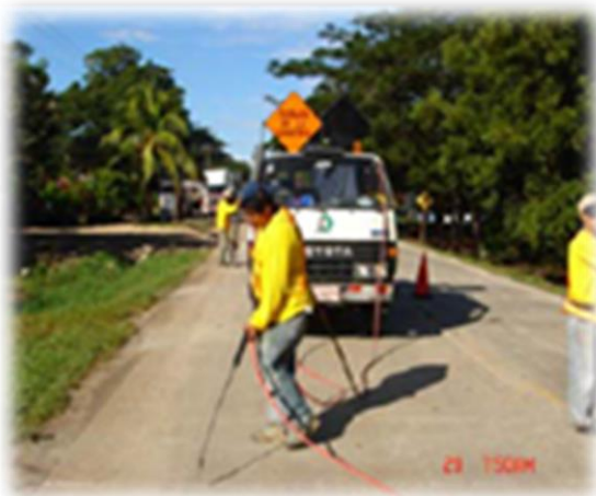
Imagen 18. Sellado de junta transversal.
