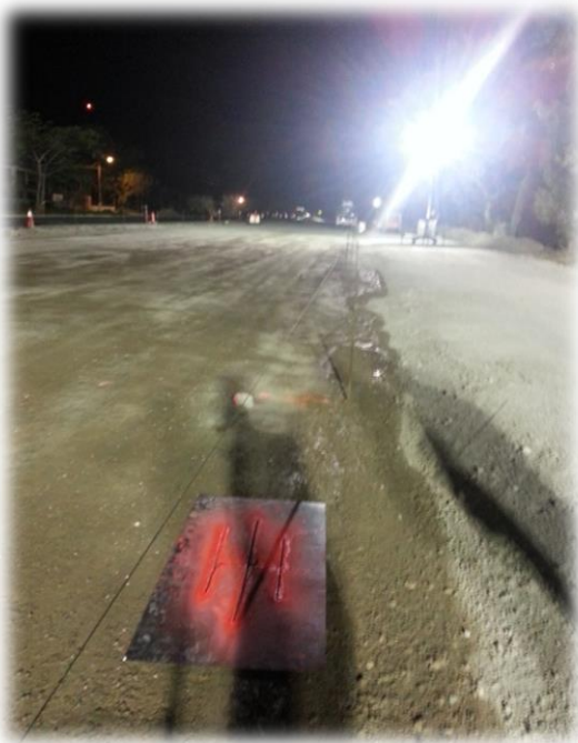
Imagen 5. Iluminación y demarcación con conos a lo largo del tramo por pavimentar.
