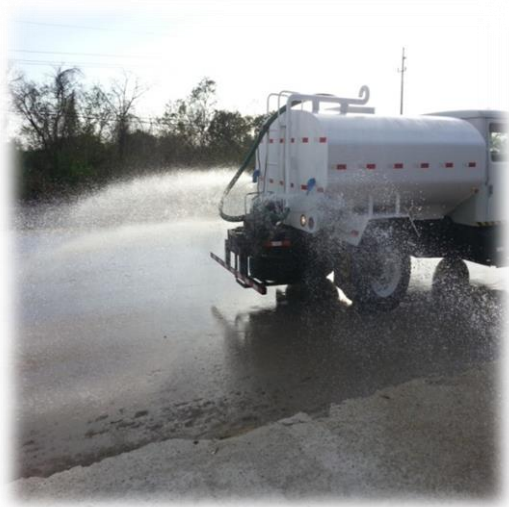
Imagen 6. Humedecimiento de la superficie con camión cisterna.
