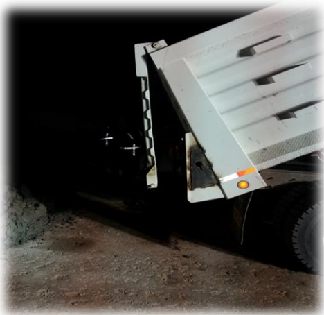
Imagen 9. Descarga del concreto.
