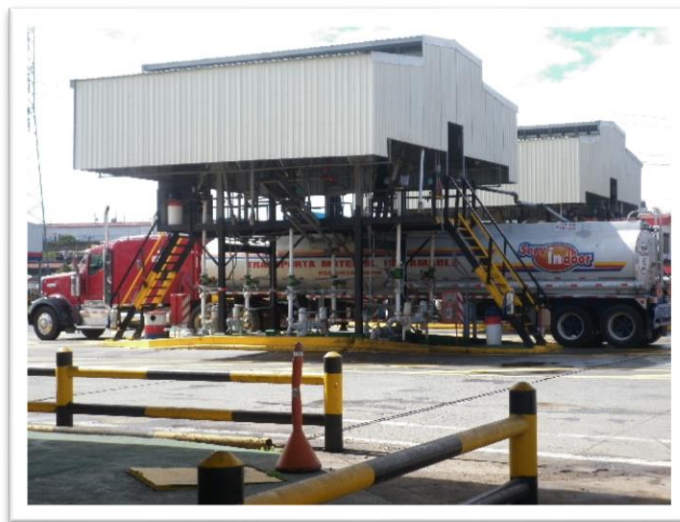
Figura 14. Área de cargaderos de combustible del plantel El Alto
