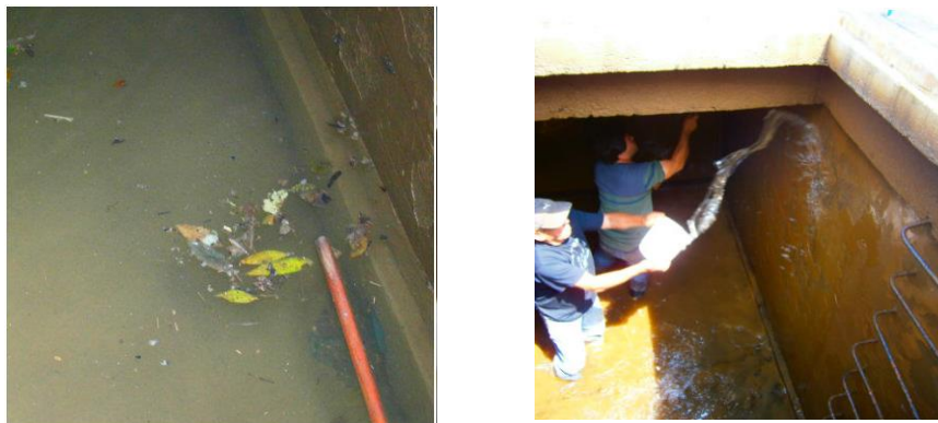
Figura 12. Limpieza de la cámara del desarenador.
