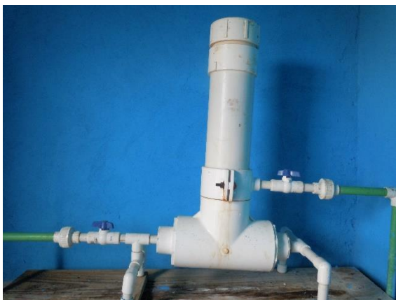
Figura A.4.9. Cloración por pastillas
