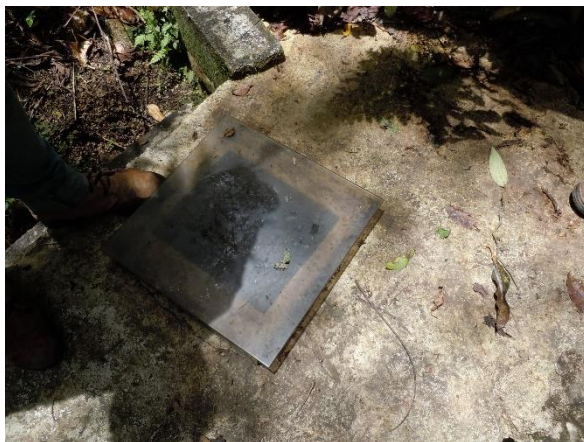
Figura 7. Tapa de vidrio de la captación de la naciente Casa Blanca, 2013.
