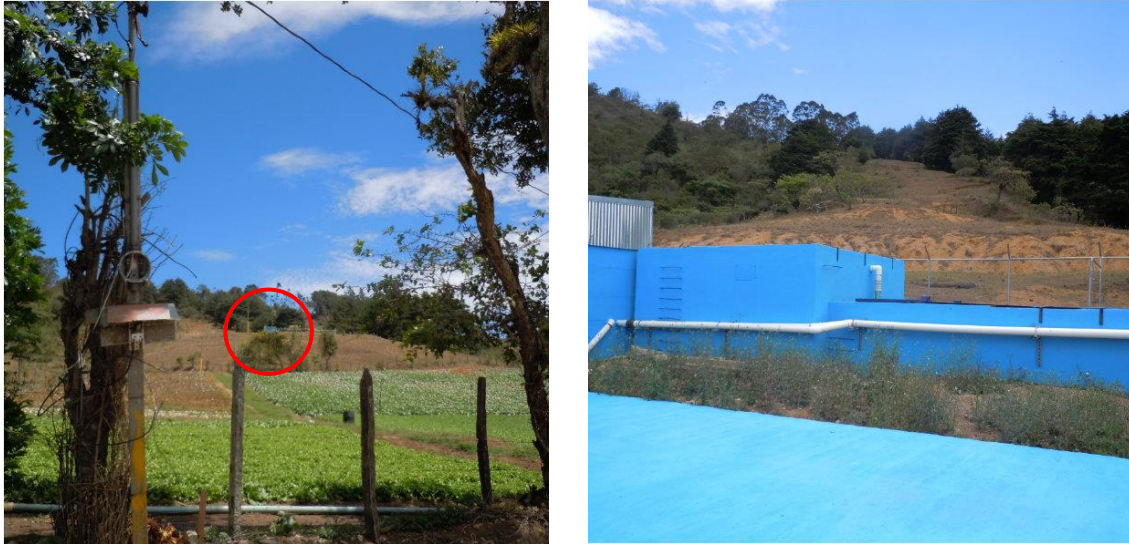
Figura 10. Planta de tratamiento de agua potable, ASADA San Isidro, 2013.
