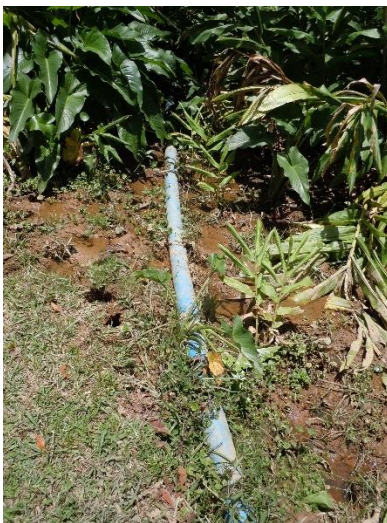
Figura 9. Tubería de conducción desde las captaciones al tanque de reunión El Cubano, 2013
