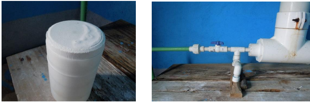
Figura 13. Pastillas de cloro al 90% de concentración y tubería de entrada de agua para diluir las pastillas.
