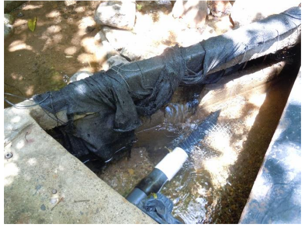
Figura A.4.3 y A.4.4 Tubos que captan el agua para distribuirlo al tanque de reunión.
