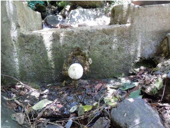
Figura A. 4.1. Captación de fuente superficial.
