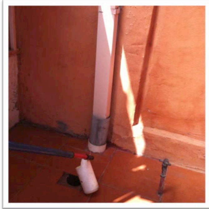
Figura 6. Vertido de agua con fluoresceína en caja de registro
