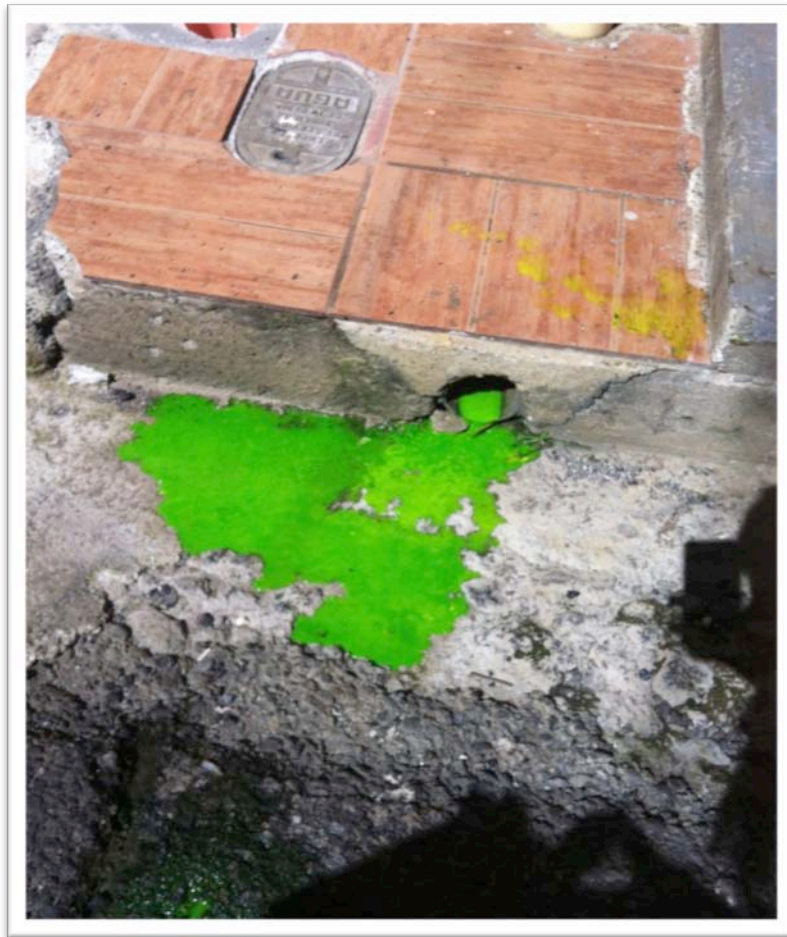
Figura 11. Prueba de tinte. Conexión pluvial correctamente conectada a la red pluvial
