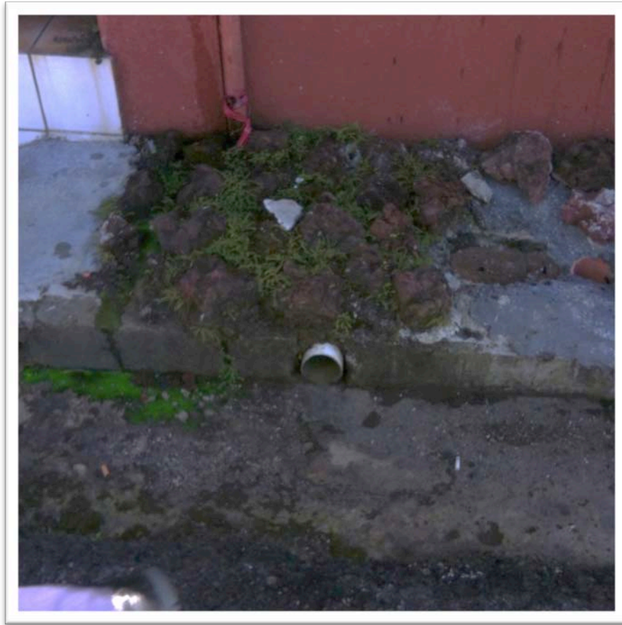
Figura 13. Propiedad con imposibilidad de acceso pero se observa que está conectada correctamente a la red pluvial
