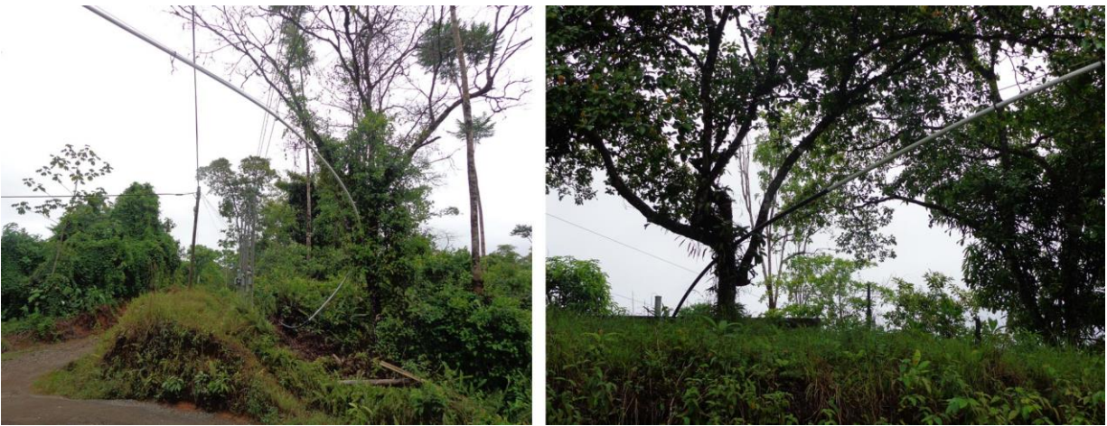
Figura 21. Tramo aéreo conducción La Gringa, antes de llegar al Tanque Bijagua. Fuente: Elaboración propia.
