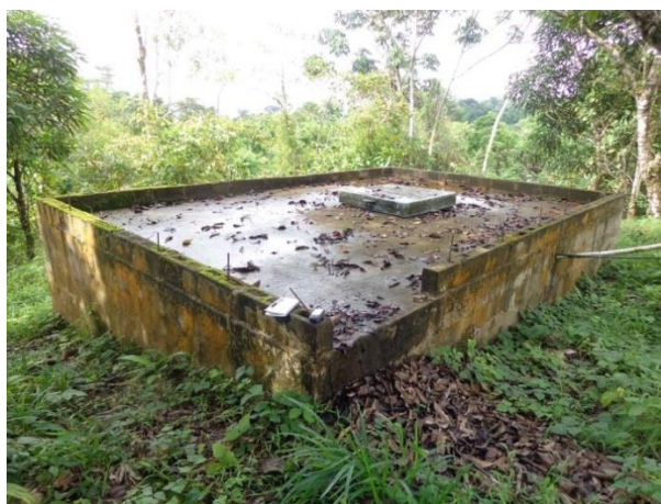
Figura 23. Tanque Bijagua. Construido con bloques de concreto, no se encuentra pintado ni resguardado con malla perimetral. Fuente: Elaboración propia.
