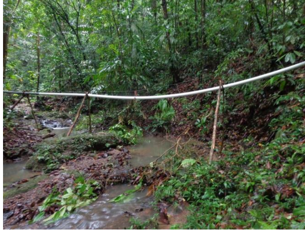
Figura 20. Conducción La Gringa, paso sobre la quebrada sostenido de forma artesanal por medio de troncos. Fuente: Elaboración propia.
