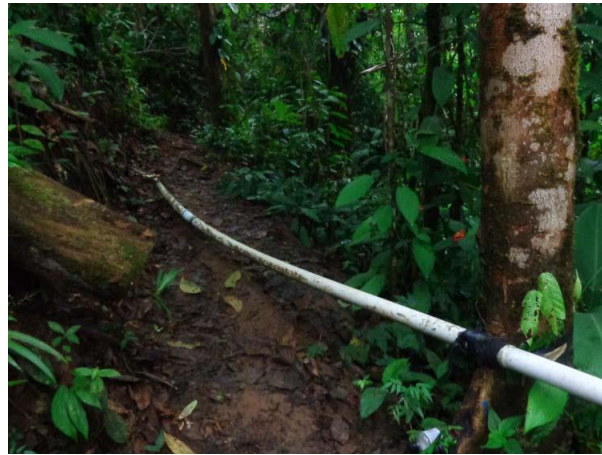
Figura 18. Conducción La Gringa, tramo por sendero; no se observa un suelo rocoso por lo que sería factible enterrar la tubería. Fuente: Elaboración propia.
