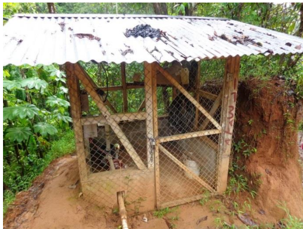
Figura 22. Caseta de bombeo.
