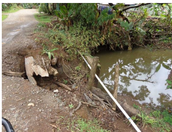
Figura 26. Tubería sin estructura de soporte ni anclajes a los extremos; vulnerable especialmente en época lluviosa. Fuente: Elaboración propia.
