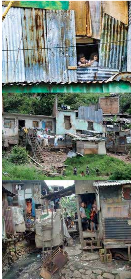
Figura 21. Viviendas de mala calidad. alrededor de 380 mil precarios y 185 mil viviendas de mala calidad.
