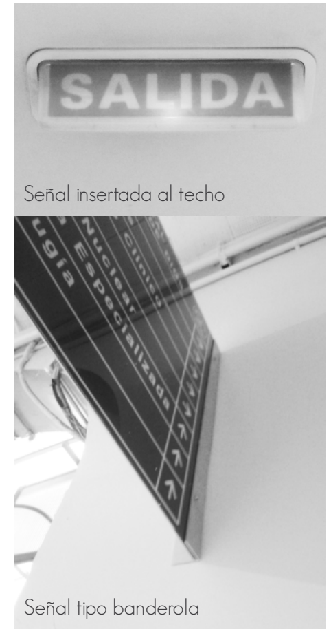
Figura 30. Ejemplos de elementos tipo banderola e insertos al techo.
