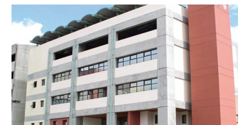
Figura 1. Edificios que conforman el HNN y sus respectivos años de fundación.
