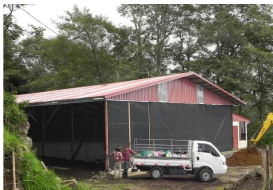
Figura 3. Vista externa de la compostera concluida, y recibo de residuos orgánicos para primera prueba piloto de composteo
