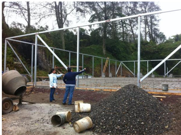
Figura 2. Visita al sitio en construcción, inicios del 2013.
