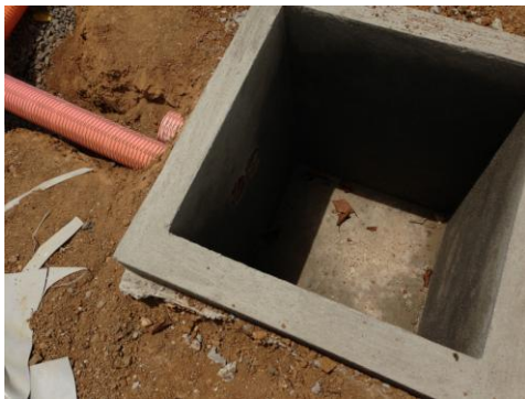
Figura 21. Avances de construcción de estanque para el cultivo microalgal, ITCR, 2012 y 2013.
