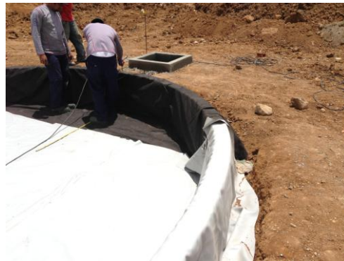
Figura 21. Avances de construcción de estanque para el cultivo microalgal, ITCR, 2012 y 2013.
