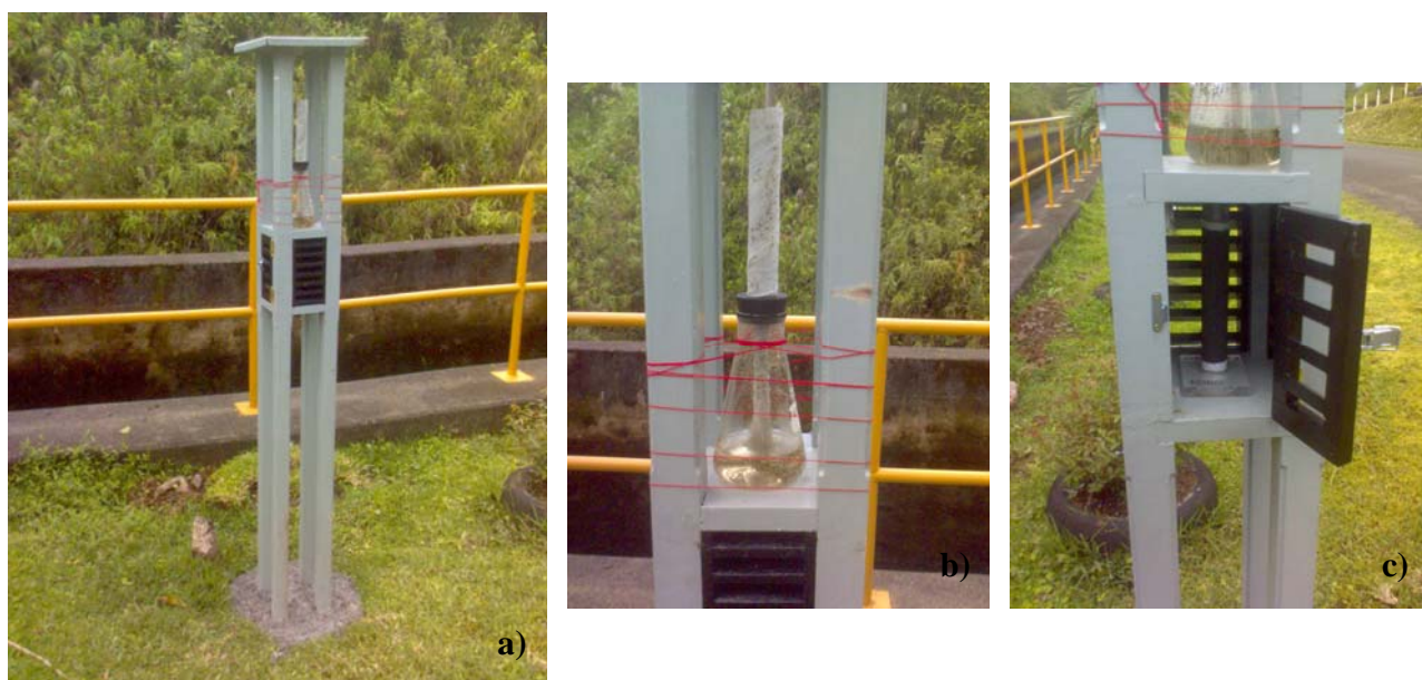
Figura N° 11. Estación de monitoreo ambiental. (a) Estación completa, (b) detalle de la vela húmeda para determinar cloruros, y (c) detalle de la vela de plomo para determinar sulfatos.
