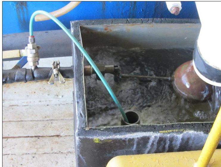
Figura 4.3.12 Sistema de reposición de agua del generador de hielo.
