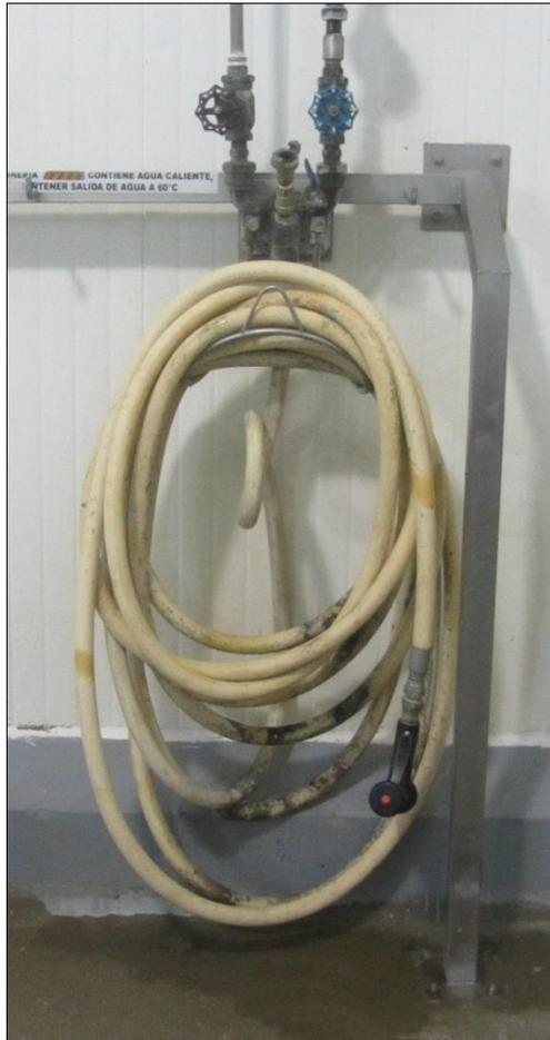
Figura 4.3.14 Estación de manguera de agua fría y caliente.
