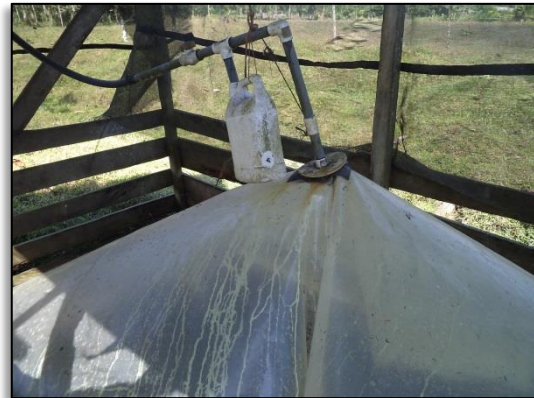
Biodigestor en funcionamiento
