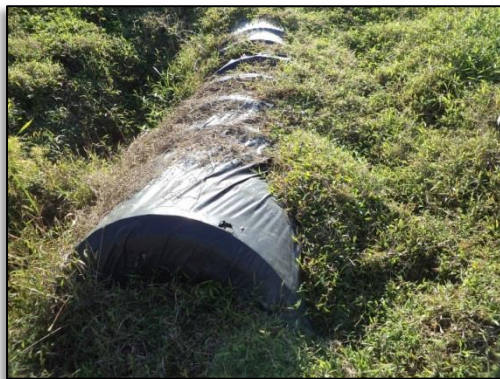
Drenaje de un Tanque Séptico
