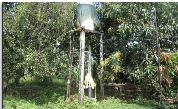
Tanque de almacenamiento
