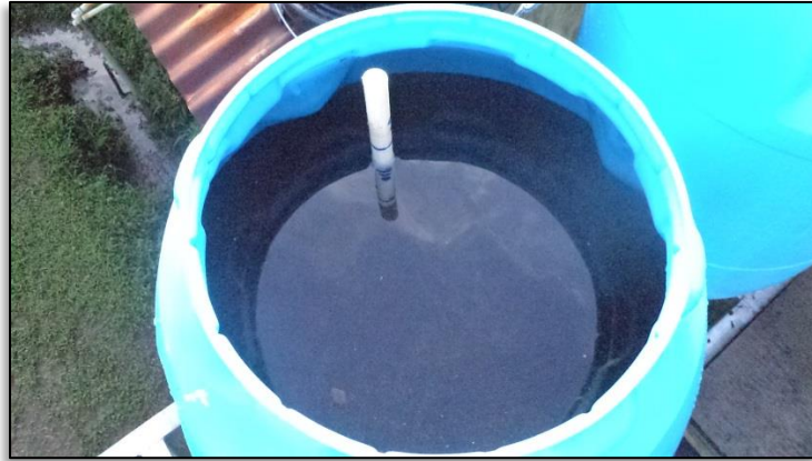
Figura 28. Tubo de pvc introducido en el tanque #3.
