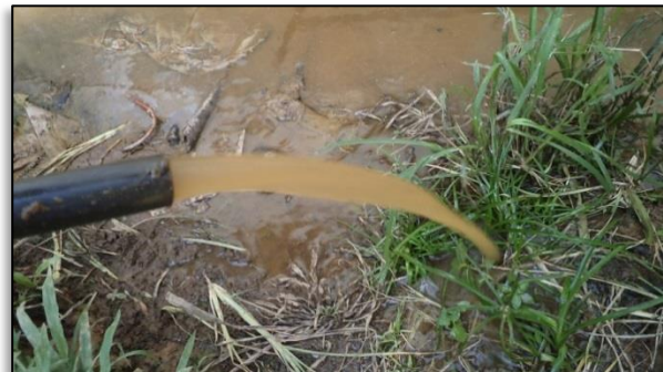
Tubería conectada al pozo
