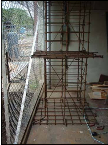
Estructura base de los cimientos de las torres monopolares.
