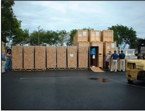
Llegada de materiales y equipos a bodegas. En la foto se esta revisando que los equipos no vengan golpeados y sean los correctos.
