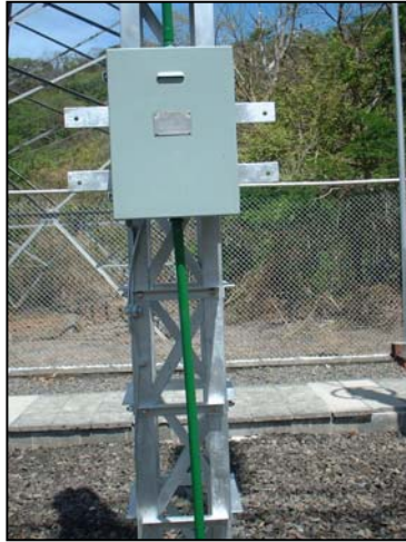
Montaje del sintonizador AKE.
