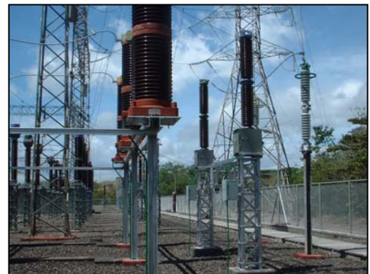
Montaje de los condensadores de acople sobre las torres monopolares.
