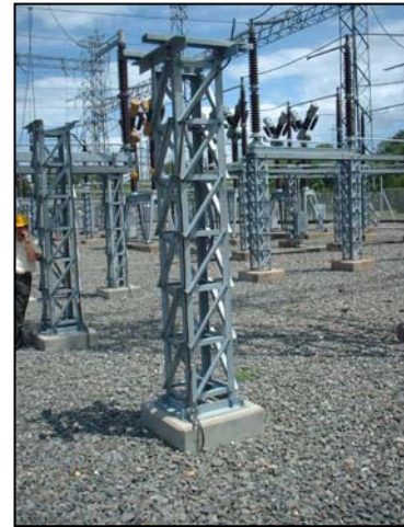
Montaje de la torre monopolar.
